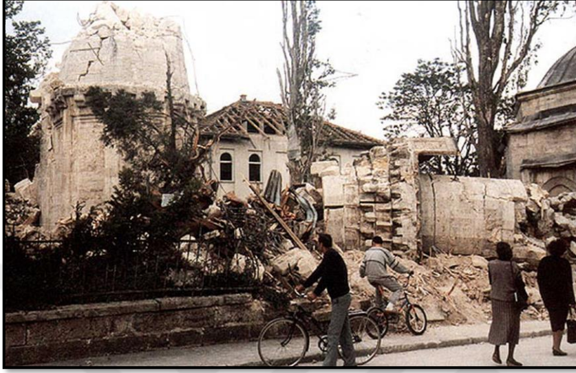
Şekil 15. Ferhad Paşa Camii harap halde, 1993
