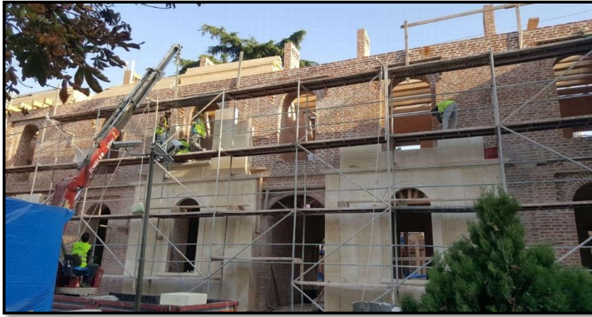
Şekil 133. Ön cephe taş kaplama yapılması, 21 Kasım 2019
