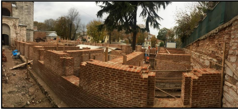
Şekil 122. Zemin kat tuğla duvar örülmesi, 26 Kasım 2018
