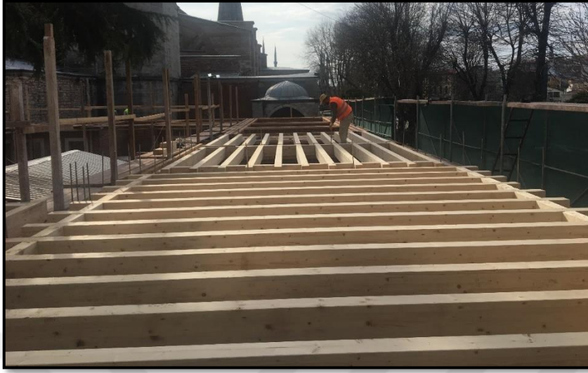
Şekil 125. Döşeme strüktürü olarak kullanılan lamine ahşap kirişler, 01 Şubat 2019
