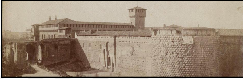
Şekil 1. Sforza Kalesi Luca Beltrami'nin restorasyonundan önce, 1894-1895 dolaylarında
