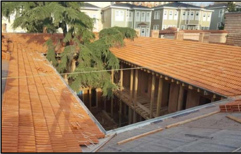
Şekil 137. Membran döşendikten sonra kiremit döşenirken, 27 Ocak 2020
