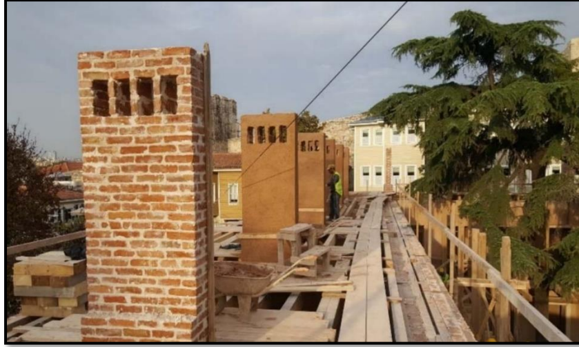
Şekil 134. Tuğla çatı bacalarının ve horasan sıvalarının yapılması, 21 Kasım 2019
