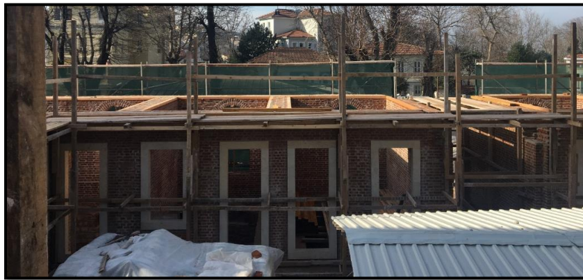
Şekil 124. Yerlerine montajı yapılan küfeki taş söveler, Ocak 2019
