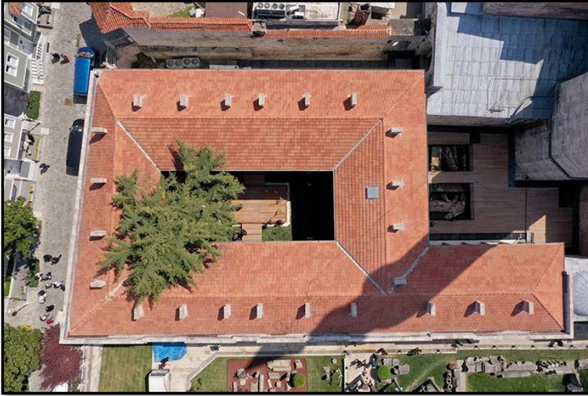
Şekil 141. Yeniden yapılan Ayasofya Fatih Medresesi'nin çatı görünümü, 2022
