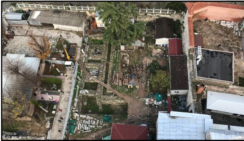
Şekil 104. Ayasofya Fatih Medresesi yapı alanı teslim durumu – Ayasofya kuzeybatı minaresinden bakış, 11 Aralık 2017
