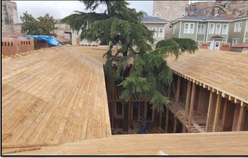
Şekil 136. Lamine kirişlerin üzerine oturan çatı, 17 Ocak 2020
