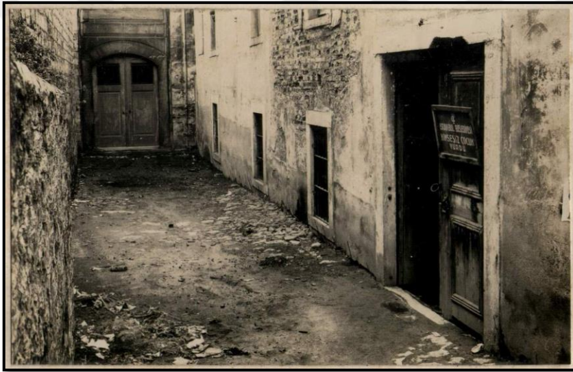
Şekil 98. Yıkıtılmadan önce Ayasofya Fatih Medresesi'nin Soğukçeşme Sokağı'ndan çekilmiş arka cephesi – Arka kapısında “İSTANBUL BELEDİYESİ KİMSESİZ ÇOCUK YURDU” tabelası bulunmakta, 26 Aralık 1934
