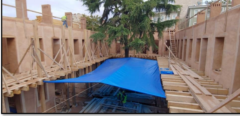
Şekil 129. Revak döşemesi ahşap lamine kirişleri, 28 Kasım 2019
