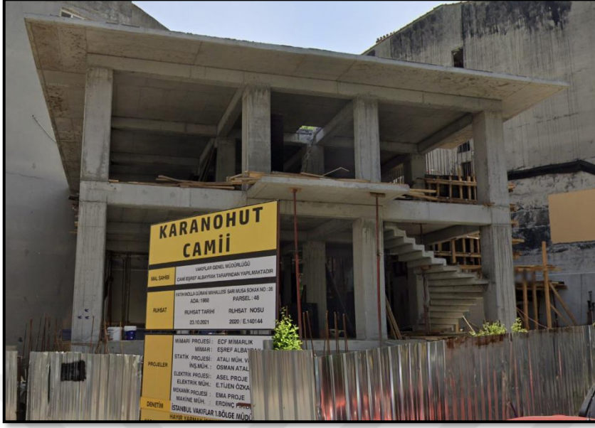
Şekil 68. Kara Nohut Camii inşaat halinde, 2022
