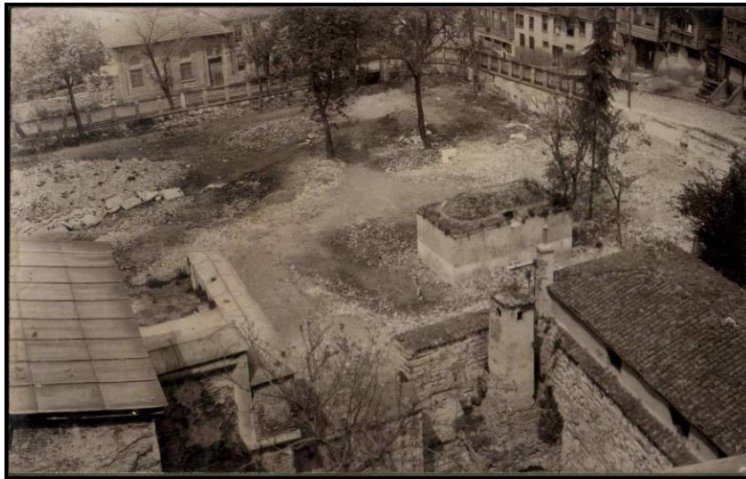
Şekil 173. Ayasofya'nın kuzeybatı minaresinden yıkılmış medrese arsasına (arsa içinde henüz yıktırılmamış su sarnıcı görülmektedir.), Caferiye Sokak ve Soğukçeşme Sokağı'na bakış, 14 Nisan 1937
