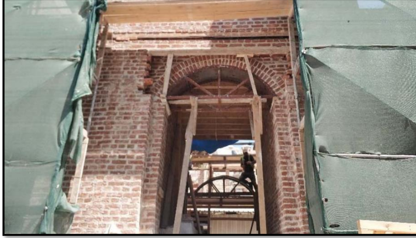
Şekil 127. Demir profil ve sacdan yapılan tuğla kemer kalıbı 09 Temmuz 2019
