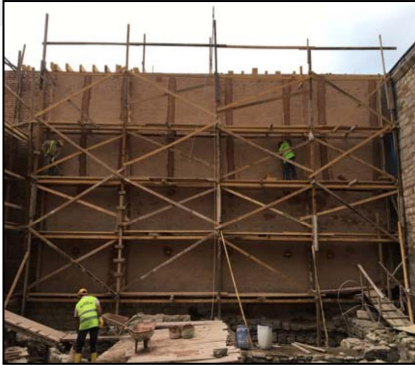
Şekil 128. Dış cephelerde horasan sıva işlemi, 25 Eylül 2019
