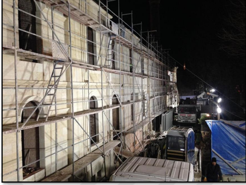
Şekil 138. Ön cephe taşları ve çatı parapetleri tamamlanırken, 24 Ocak 2020
