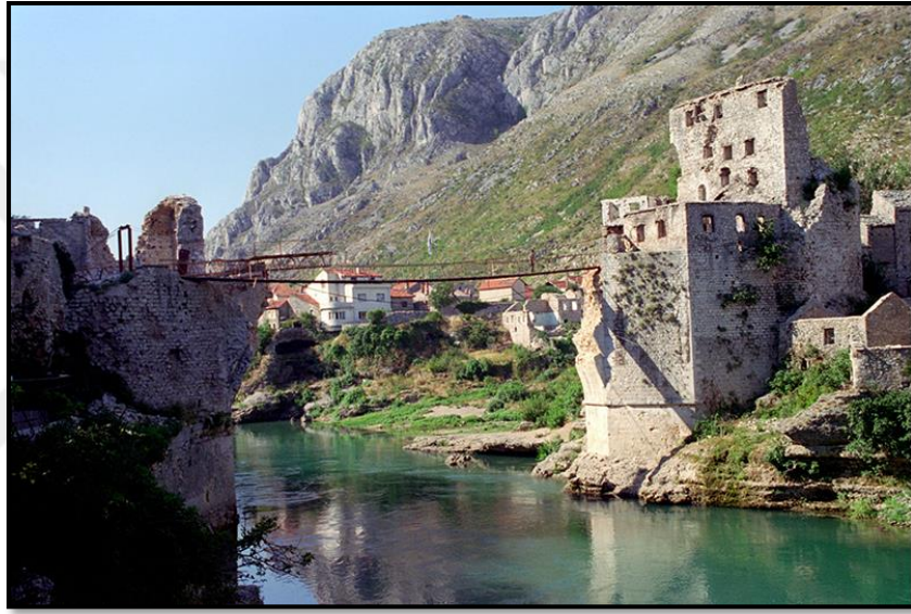
Şekil 9. Mostar köprüsü yıkılmış halde
