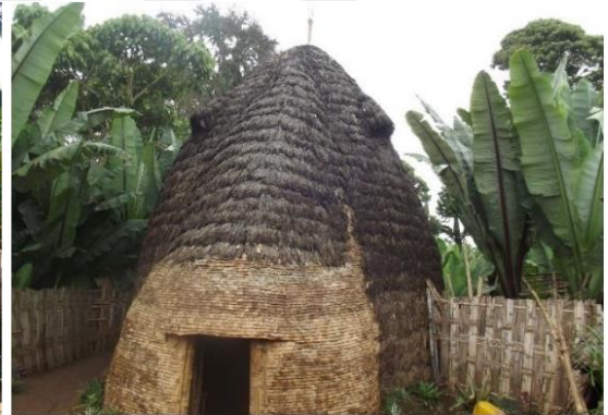
Şekil 3.78. Gamo evinde çatı kaplama malzemesinin değişimi.
