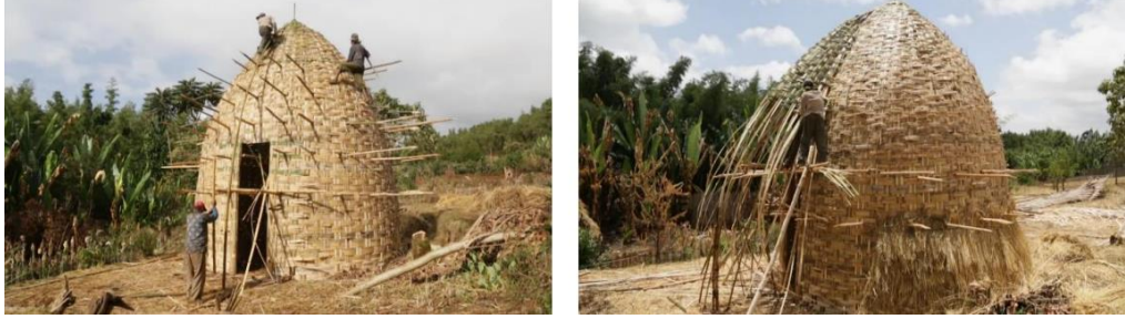
Şekil 3.75 Gamo evinde zono kısmının örülmesi.
