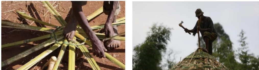
Şekil 3.74. Gamo evinde konut çatısının tepe noktasının tamamlanması.
