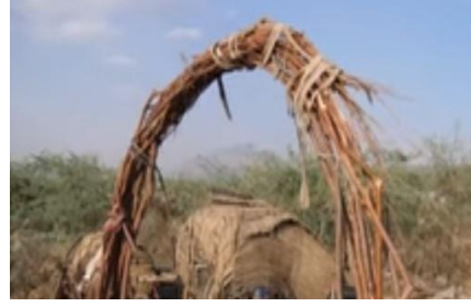
Şekil 3.43. Afar konut inşasında kullanılan kurutulmuş ve eğilmiş ağaç dalları.
