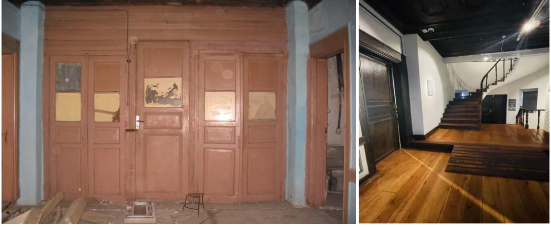
Şekil 4.79 Zemin katta eski kullanımında yapılmış olan ahşap bölme duvar ve kapı (solda), alanın yeni hali (sağda).
