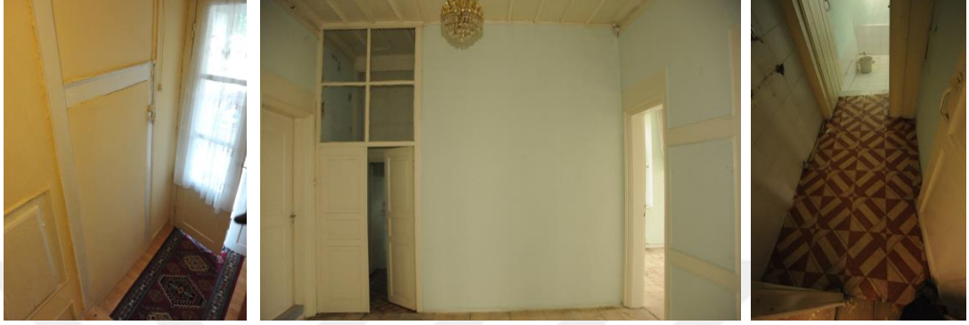
Şekil 4.130 Bodruma inen merdiven üzerindeki dolgu (solda), zemin katta sofa ve merdiven arasındaki bağlantıyı kesen duvar(ortada) ve wc (sağda) (Ayşe Bayazıt Arşivinden)
