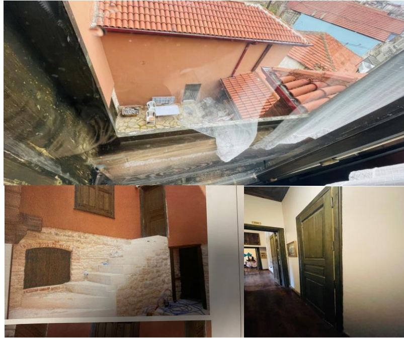
Şekil 4.90 Avlu-Arabalıktan üst kattan görünüm (üstte) ve yapıyla bağlantılı olup kapatılan avlu-arabalık kapısı (altta)
