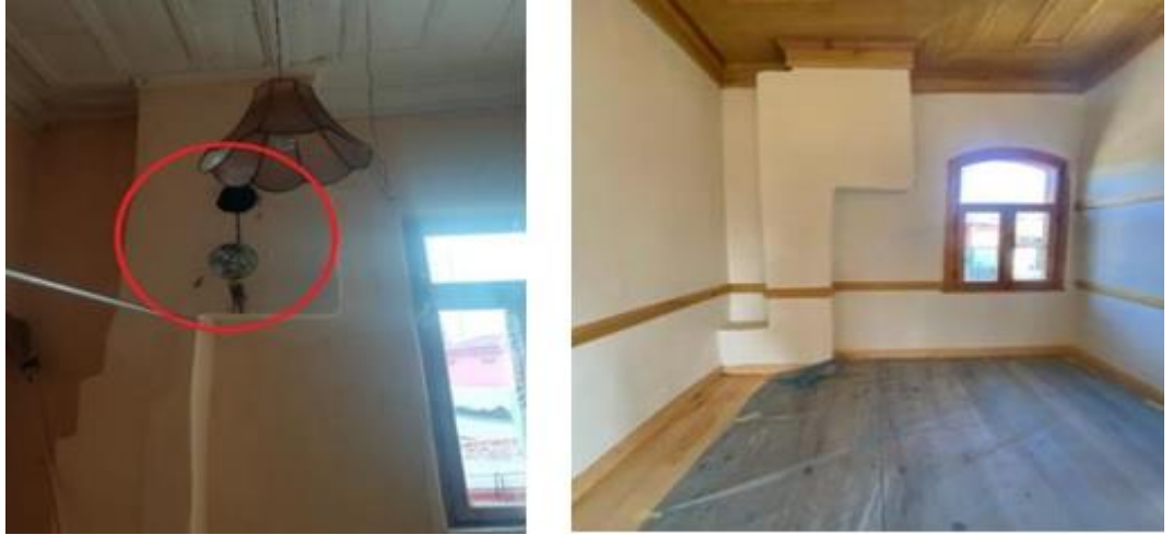
Şekil 4.10 Yapıya sonradan eklenen bacaların mevcut durumu
