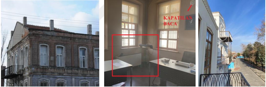
Şekil 4.136 Eski bacalar (solda), mevcut ısıtma elemanları (ortada), balkonlar (sağda)
