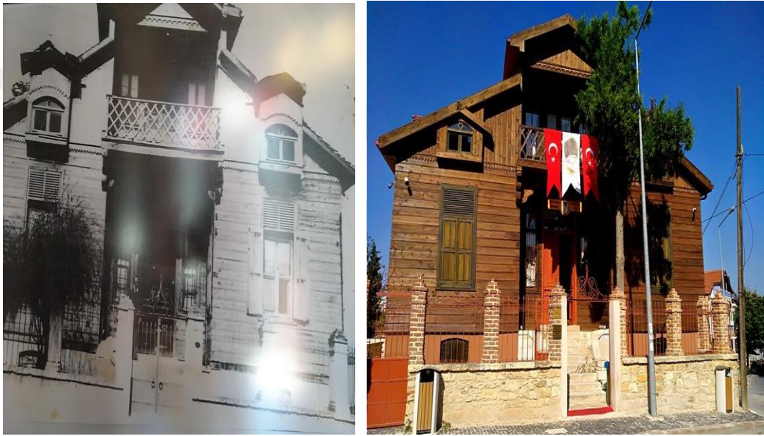
Şekil 4.86 Yapının eski ve yeni görüntüsü
