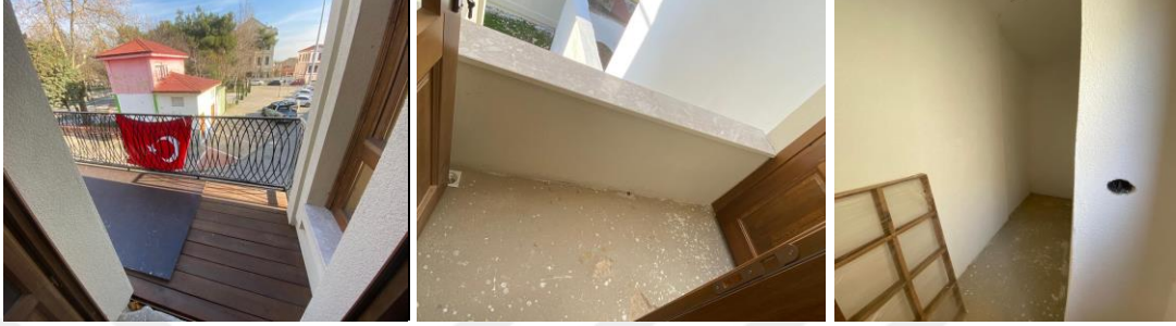
Şekil 4.143 Balkonlar ve depo
