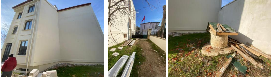
Şekil 4.144 Ek yapı, bahçe kapısı ve kuyu
