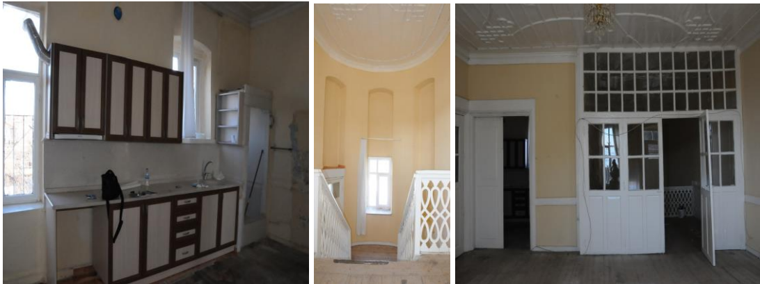
Şekil 4.134 Üst kattaki konutun mutfağı (solda), pencere dolguları ve wc kapısı (ortada), camekan (sağda) (Ayşe Bayazıt Arşivinden)
