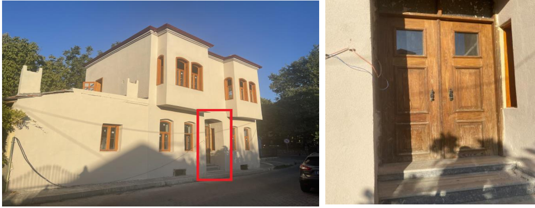
Şekil 4.3 Ana giriş kapısı ve yapının sokak ile bağlantısını sağlayan giriş merdiveni
