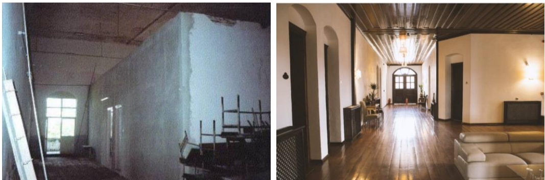
Şekil 4.119 Birinci katın eski hali (solda) (Demir, 2010) ve birinci katın yeni hali
