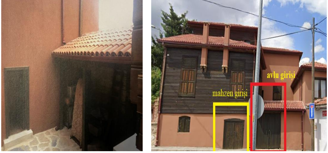
Şekil 4.91 Yeni açılan müştemilat kapısı ve kapatılan arabalık kapısı (solda), mahzen ve avlu girişi (sağda)
