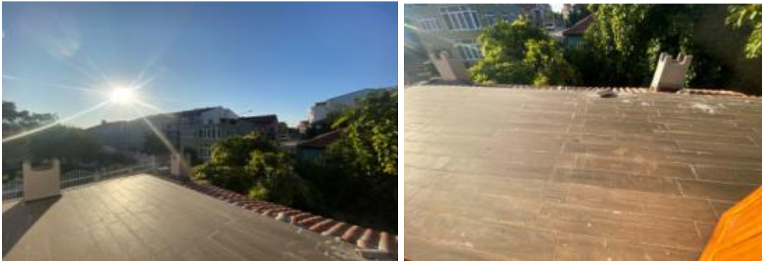
Şekil 4.19 Terasın modern malzemelerle yenilenmiş hali
