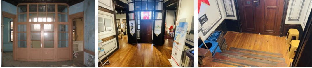
Şekil 4.80 Zemin katta giriş holünü sofadan ayıran ahşap kapı eski durumu (sağda), kapının yeni durumu (solda) ve yapının giriş holü
