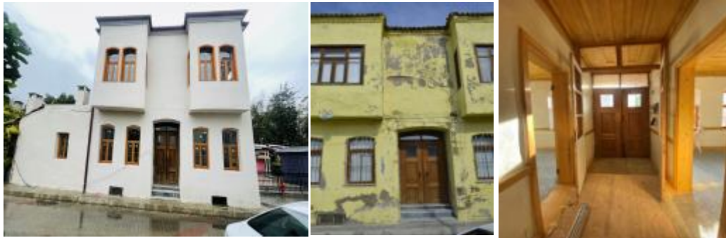
Şekil 4.4 Yapının cumbalı ön cephesinin mevcut durumu (solda), restorasyondan önce ön cephedeki pencere yapıları (ortada) (Ercüment Tekin arşivinden), giriş holü (sağda)
