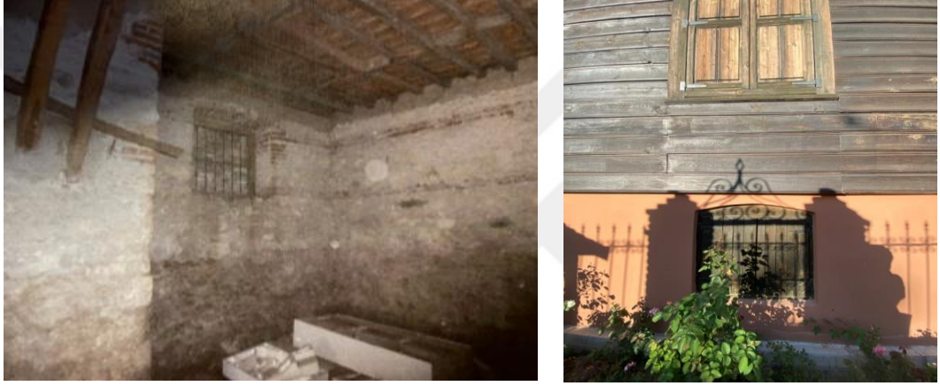
Şekil 4.94 Bodrum katta daha önce taşla kapatılmış olan pencereler açılmıştır.
