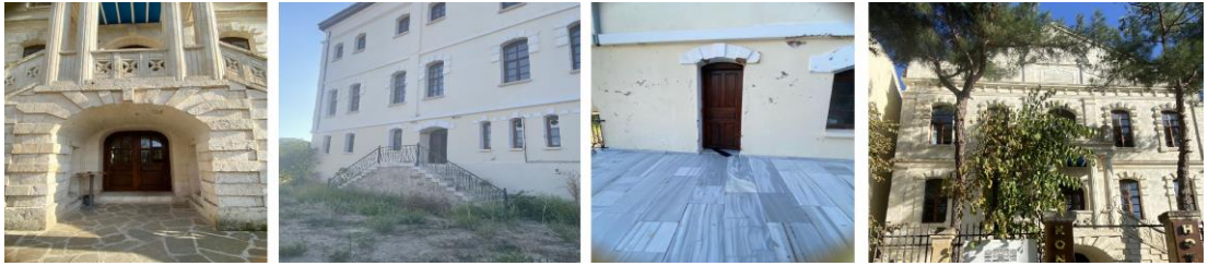
Şekil 4.105 Yapının ana girişi, bahçe girişi, servis girişi, birinci kat girişi
