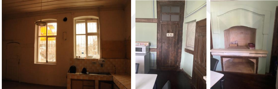
Şekil 4.131 Mutfak penceresindeki dolgu (solda), mevcut wc kapısı (ortada) ve mevcut ocak (sağda)
