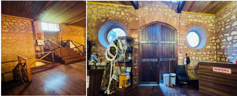
Şekil 4.42 Yapının birinci kat girişi ve yapının zemin kat girişi
