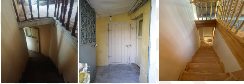
Şekil 4.32 Restorasyondan önce yapının kat merdiveni ve giriş holü (solda)(Ercüment Tekin Arşivinden), yapının günümüzde özgün haline dönüştürülen kat merdiveni (sağda)
