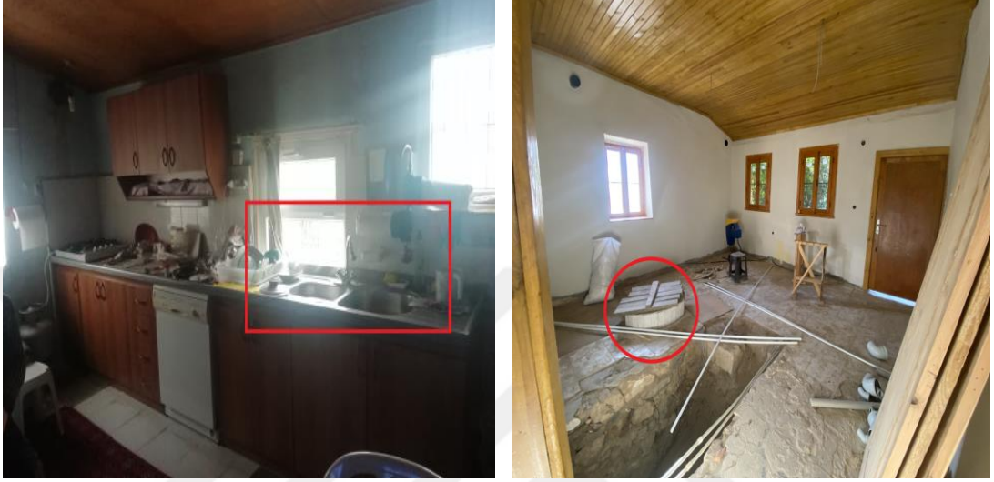
Şekil 4.12 Mutfaktaki su kuyusu restorasyon öncesi (solda) ve sonrası (sağda)
