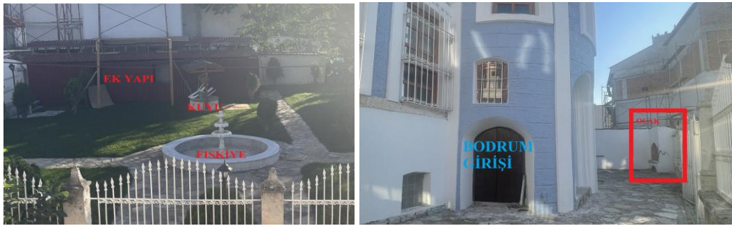
Şekil 4.127 Mevcut bahçede bulunan ek yapı, kuyu ve fiskiye (solda), ocak ve bodrumun diğer girişi (sağda)
