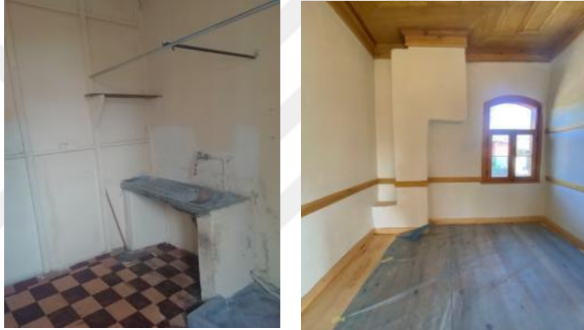
Şekil 4.29 Kullanıcıların yapının sofa mekanında üst katta oluşturulan konut için sonradan yaptığı mutfak (solda) (Ercüment Tekin Arşivinden) ve günümüzde özgün haline dönüştürülen sofa (sağda)
