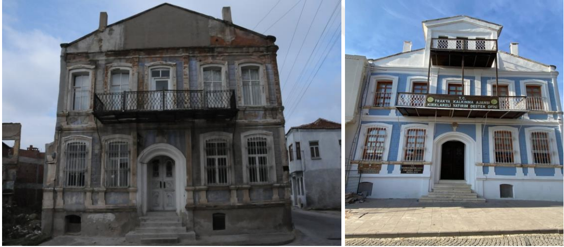
Şekil 4.129 Yapının ön cephesinin önceki durumu (solda) ve ön cephesinin mevcut durumu(sağda)
