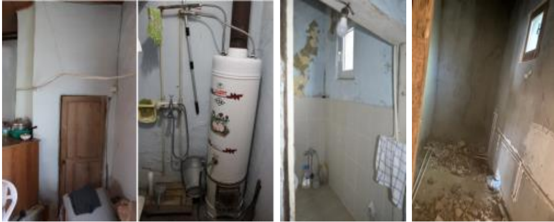
Şekil 4.24 Restorasyondan önce alt konutun banyosu (solda), üst konutun wc-banyosu (ortada) ve yapının wc-banyosunun mevcut tesisat sistemi (sağda) (Ercüment Tekin'den geliştirilmiştir.)
