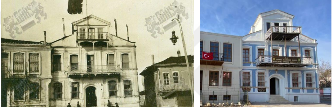
Şekil 4.122 Yapının ilk hali (Toptaş, 2012) ve mevcut hali
