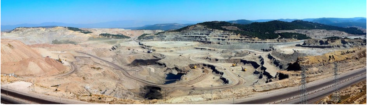
Şekil 3.13 GLİ açık işletme alanından görünüm
