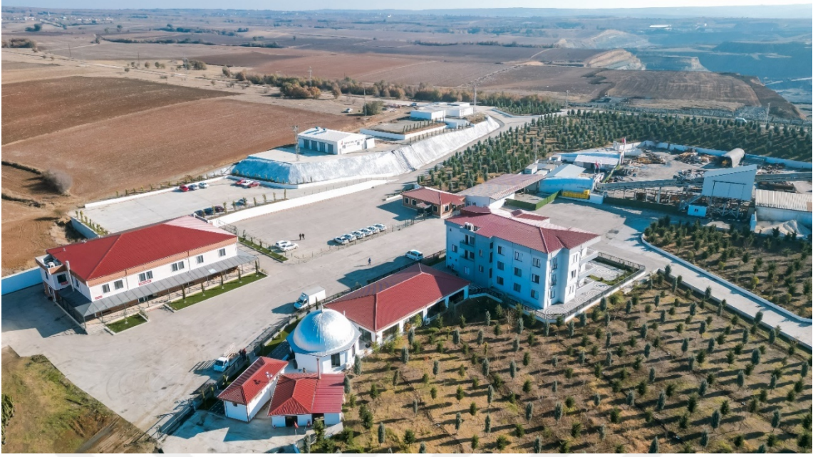
Şekil 3.41 Yerüstü Tesisleri ve ağaçlandırma çalışmaları
