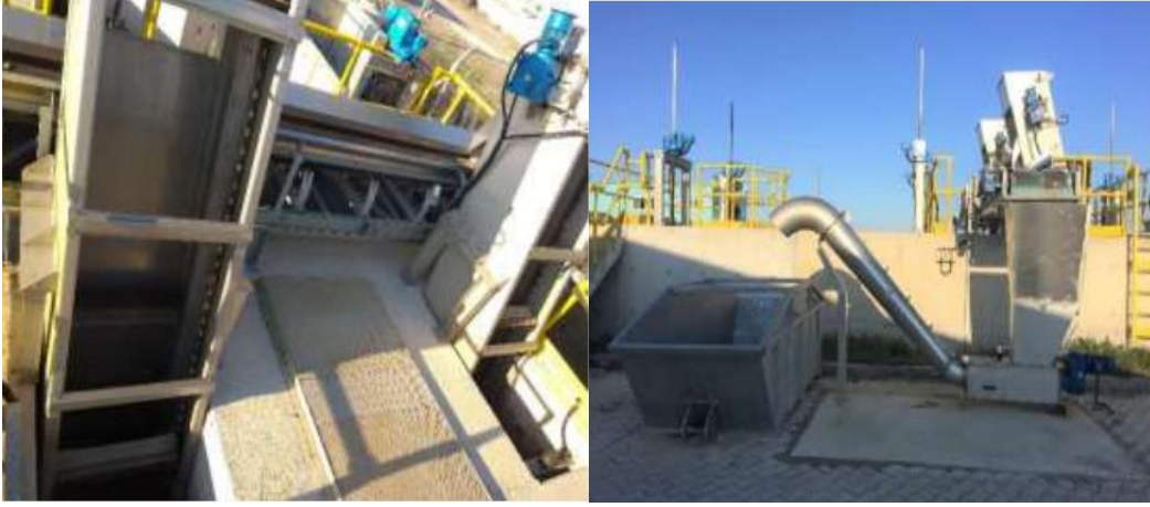
Şekil 3. 9 İnce ızgara ve ızgara pres ünitesi
