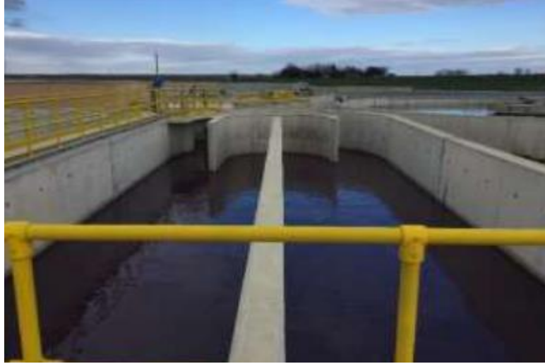
Şekil 3. 13 Anaerobik biyofosfor havuzları
