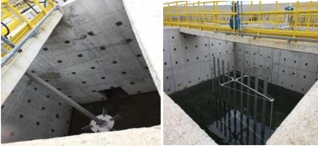
Şekil 3. 18 Hızlı ve yavaş karıştırma ünitesi
