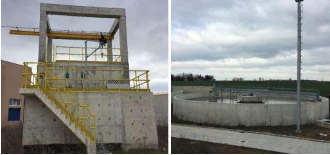
Şekil 3. 17 Biyolojik çöktürme havuzu ve geri devir hattı
