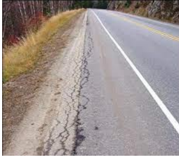
Şekil 2.3 : Esnek üstyapıda gözlemlenen kenar çatlağı[7].
