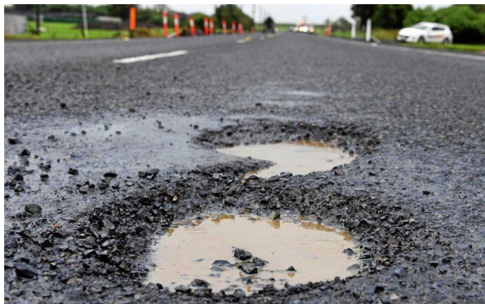
Şekil 2.10 : Esnek üstyapıda oluşmuş çukur tipi bozulma.
