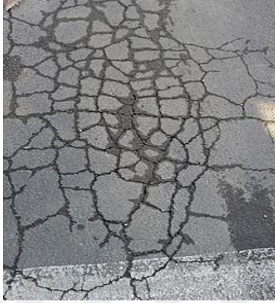
Şekil 2.2 : Esnek üstyapıda oluşmuş timsah sırtı çatlak.
