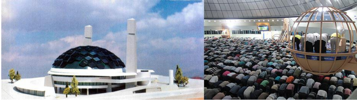
Şekil 3. 13 Danyal Tefik Çiper, Terzibaba Camii, maket fotoğrafı ve iç mekân görüntüsü, 1992 [122]
