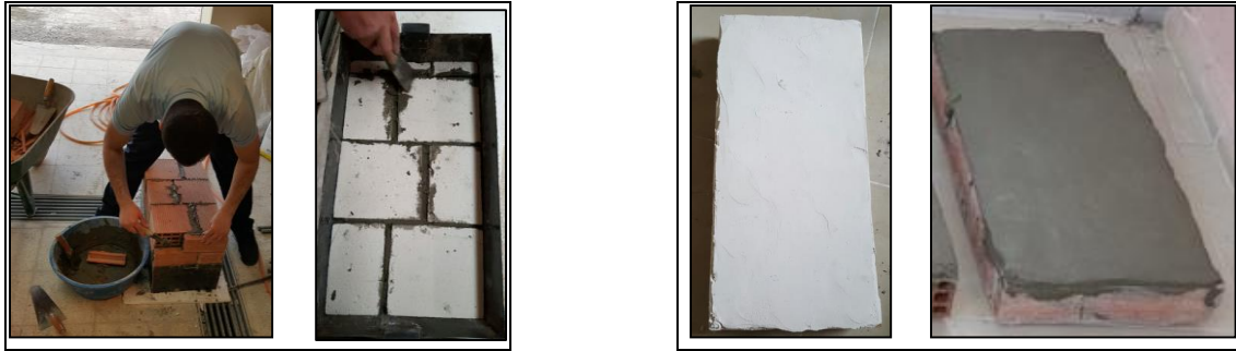
Tuğla, gazbeton duvar örümü
