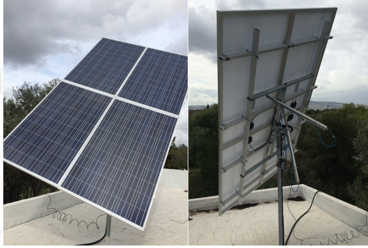
Şekil 5.1 İki-eksenli kurulu güneş takip sistemi
