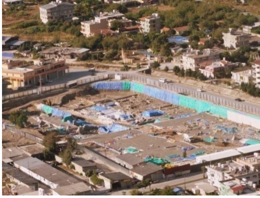
Fotoğraf - 13: Müze - Otel İnşaatı
