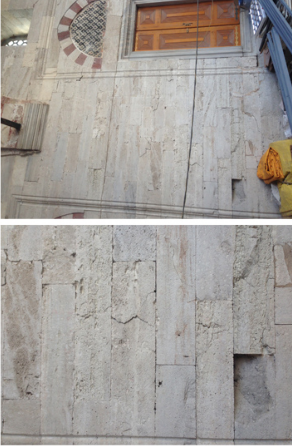
Şekil 4.4: Bayezid Camisi avlu duvarından numune alınan alan, Avlu Numune 1, Plan Kesit Numune No 5
