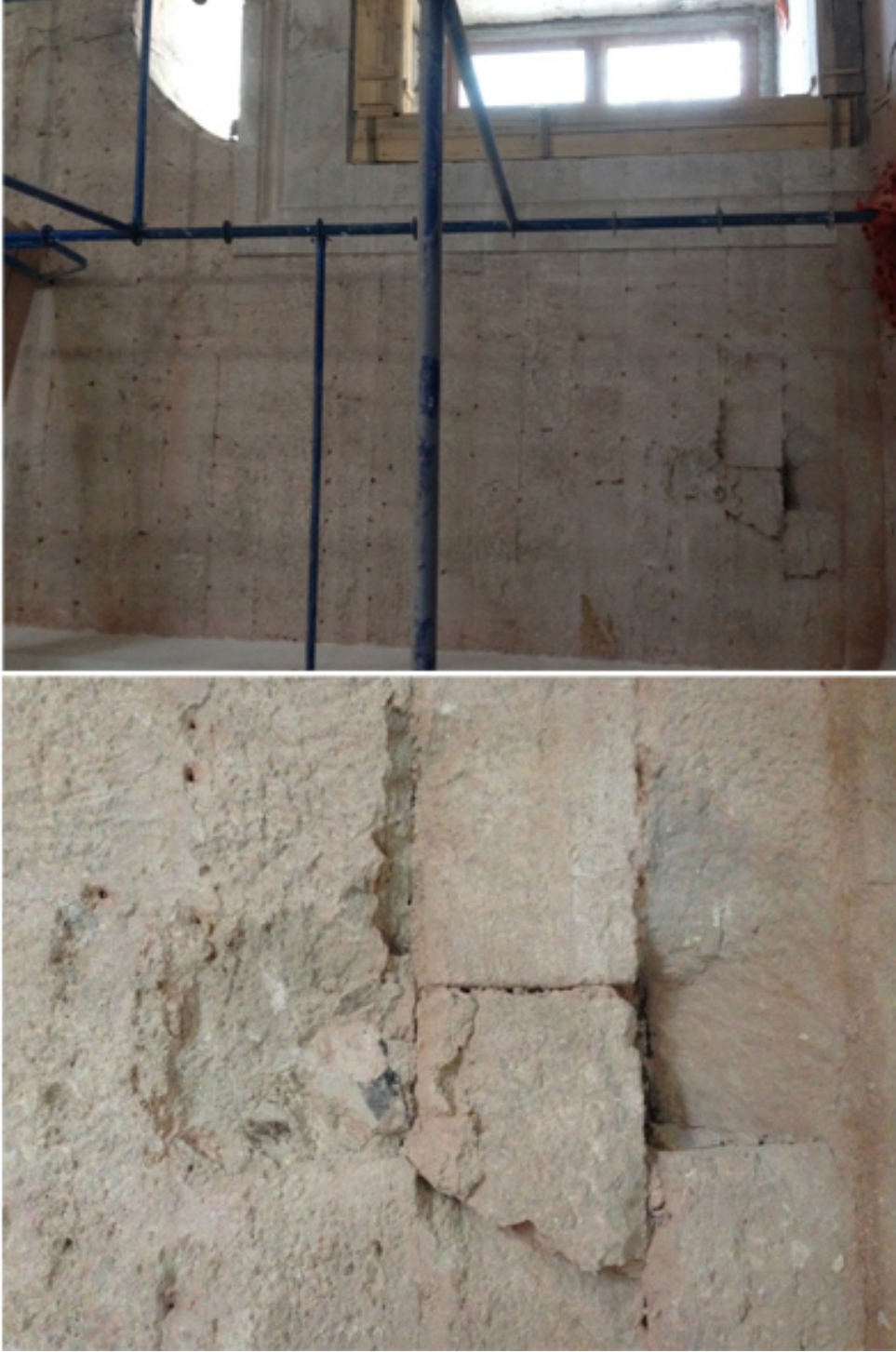
Şekil 4.6: Bayezid Camisi _ Mihrap duvarından numune alınan alan , Mihrap Duvarı Numune No 4
