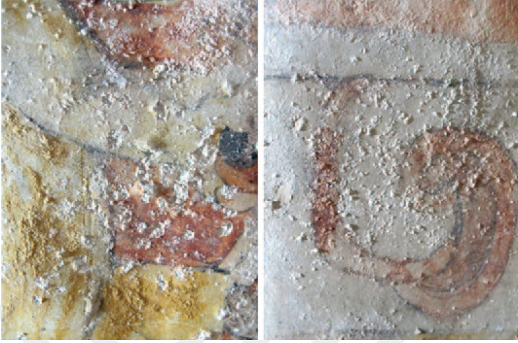
Şekil 3.14: Meksika'nın Ixcaquixtla bölgesinde duvar bezemelerinde gözlemlenen tuz kristallenmesi etkisi ile oluşan mekanik gerilme ve kalsiyum karbonat kaynaklı korozyon
