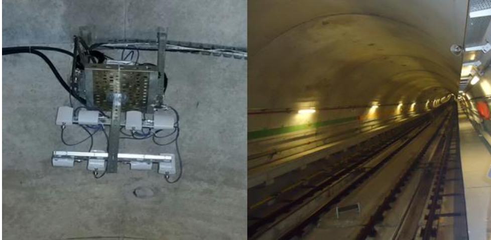
Şekil 4.19 Tünel ortası erişim noktası cihazı
