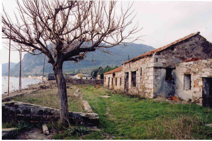
Resim III.14. Küçükkuyu sahilinde muhtemelen geç Osmanlı Döneminde yapılmış ve Erken Cumhuriyet döneminde kullanılmaya devam etmiş terk edilmiş bir zeytinyağı fabrikası.
