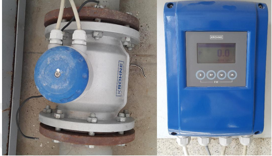
Şekil 3. 5. Elektromanyetik debimetre ve göstergesi
