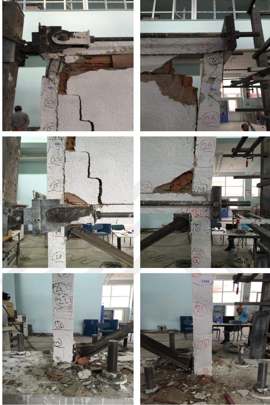
Şekil 4.25. Deney sonunda merkezi X çelik çapraz çerçeve numunesi (DN3-XÇAP) düğüm noktaları hasarları.
