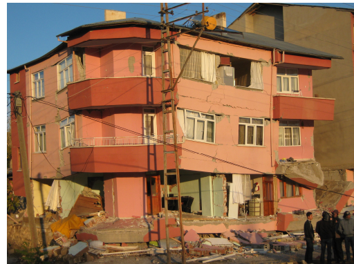
Şekil 1.10. Yumuşak kat sonucu oluşan bina hasarları (2011 Van depremi- Murat ÖZTÜRK'ün arşivi).
