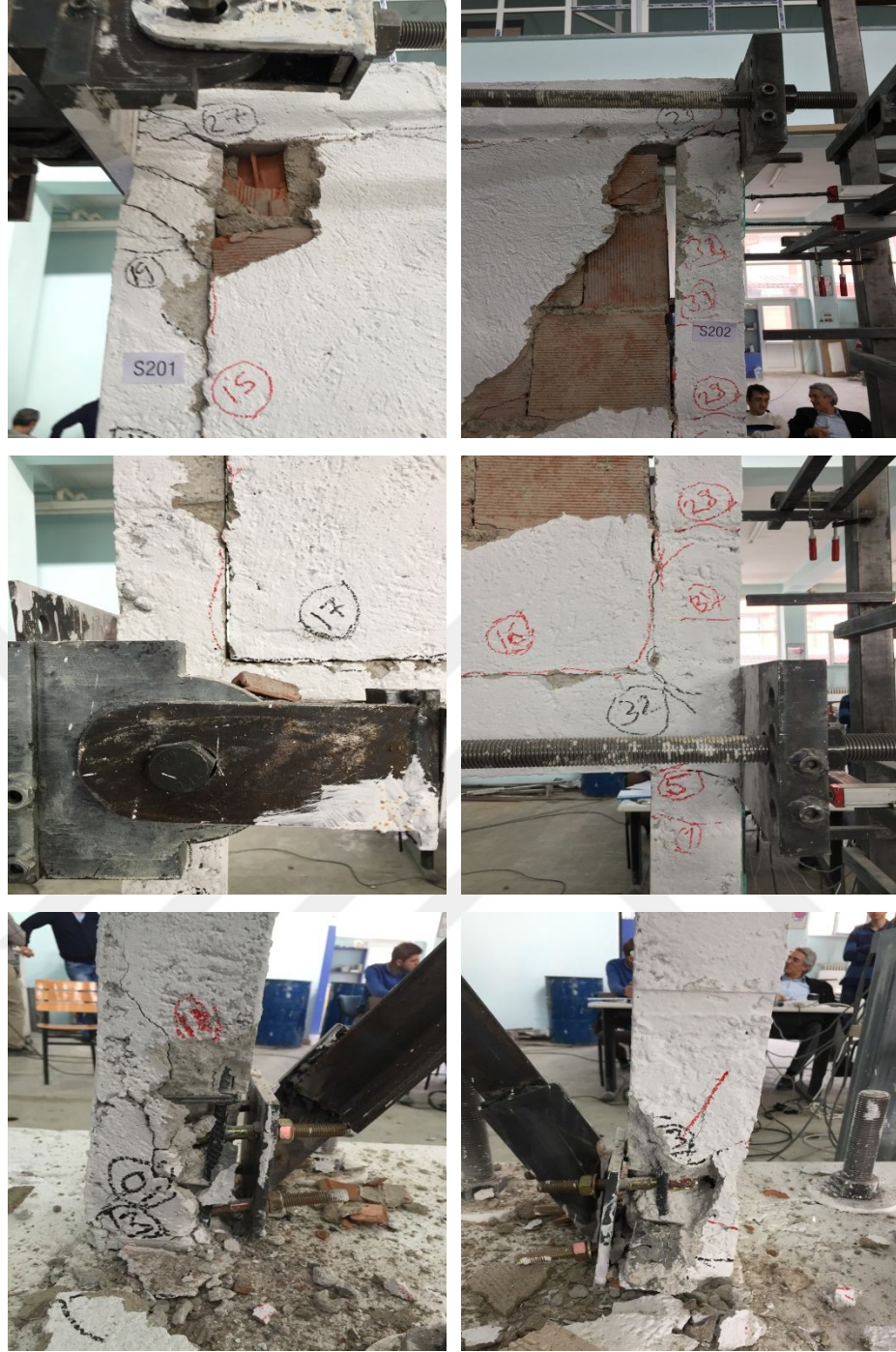
Şekil 4.34. Deney sonunda merkezi V çelik çapraz çerçeve numunesi (DN4-VÇAP) düğüm noktaları hasarları.
