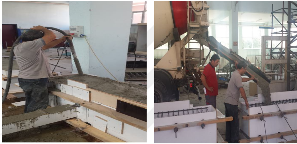
Şekil 3.9. Numunelere beton dökümü.
