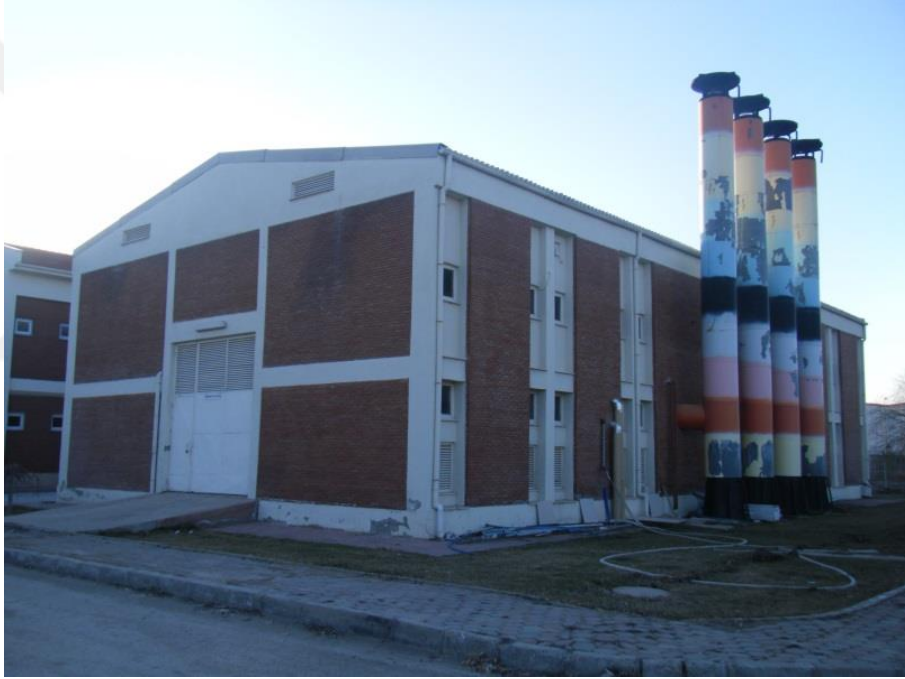
Şekil 3.14. Mühendislik Fakültesi bloklarına ait ısı merkezi
