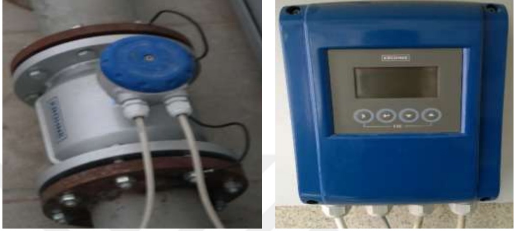
Şekil 2.5. Elektromanyetik debimetre ve dijital göstergesi
