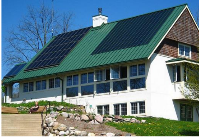
Şekil 3. 3 Yapı kabuğunda PV sistem uygulamasına örnek [25]
