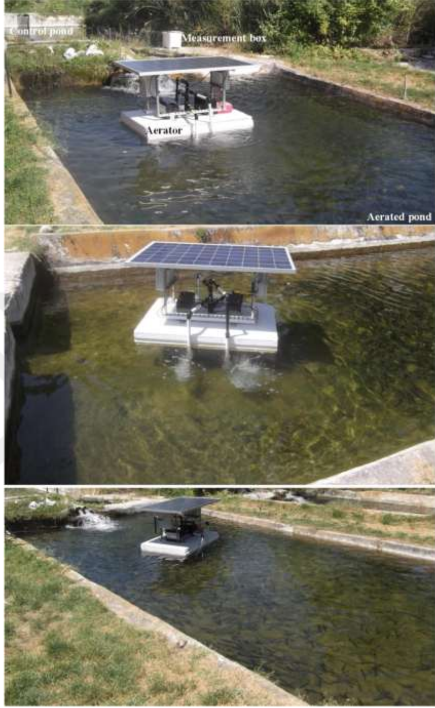
Şekil 9 havalandırma sistemi test denemeleri (Figure 5.29)
