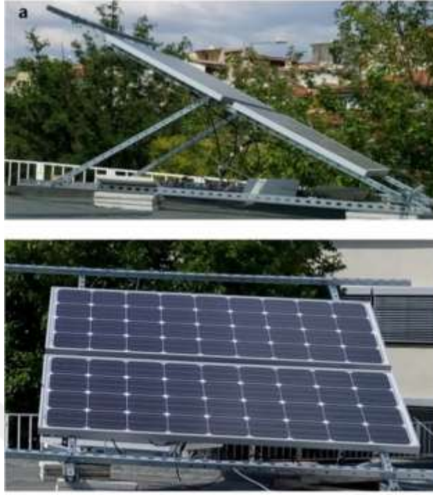
Şekil 5 Açılabilir ayarlı monokristal güneş panelleri ve konstrüksiyonu (Figure 5.7)
