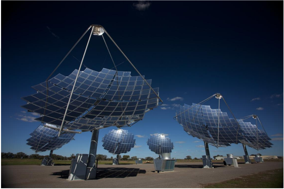
Şekil 4.5 Yoğunlaştırılmış fotovoltaik sistemlerden oluşturulmuş bir güneş tarlası (Electric-vehiclenews, 2013)
