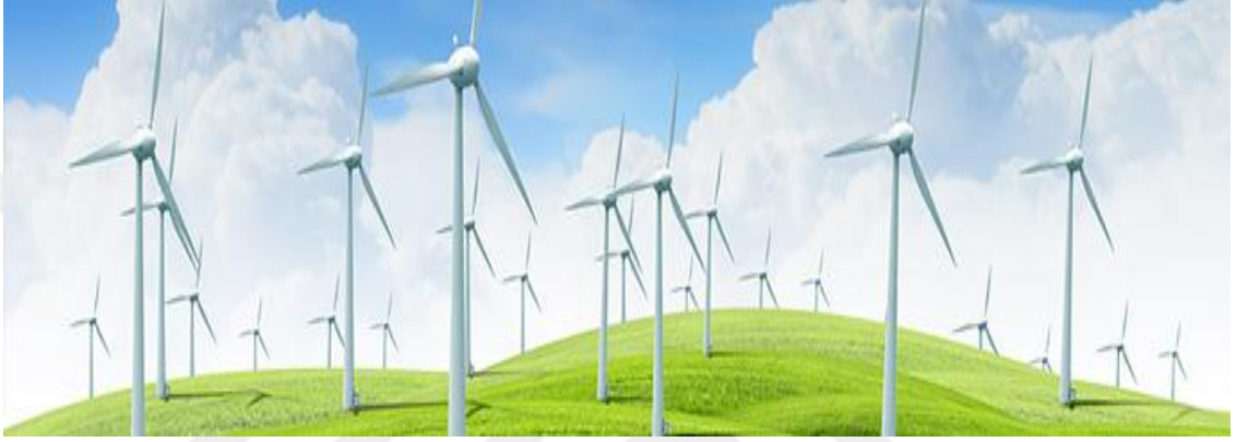
Şekil 2.5. Rüzgâr enerji santrali (ETKB, 2016).
