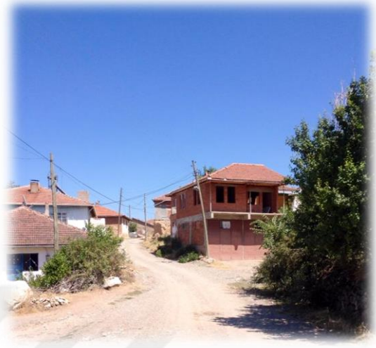
Resim 100. Acısu Köyünde Dam evlerin yerine yapılmaya devam eden Betonarme Evler, Acısu Köyü, Haziran 2012,M.Özgen.
