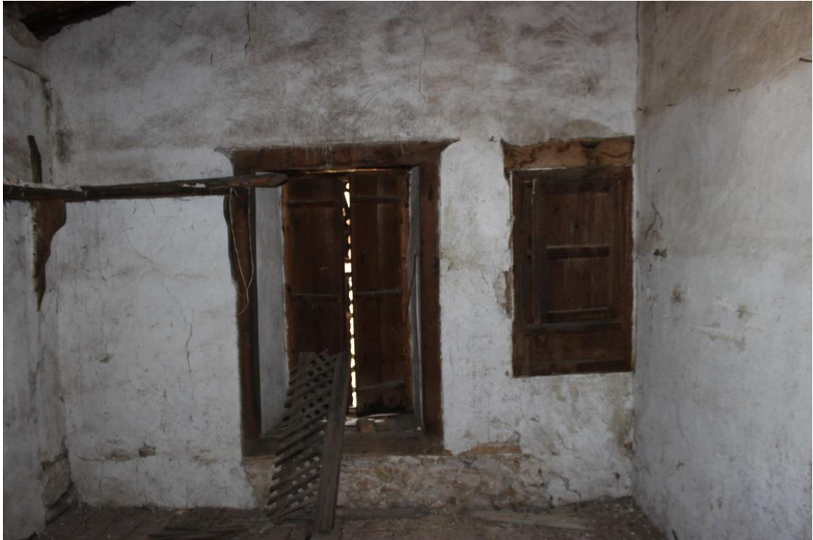
Resim 4.23. Oda mekânı içten kepenkli dıştan kafesli penceresi
