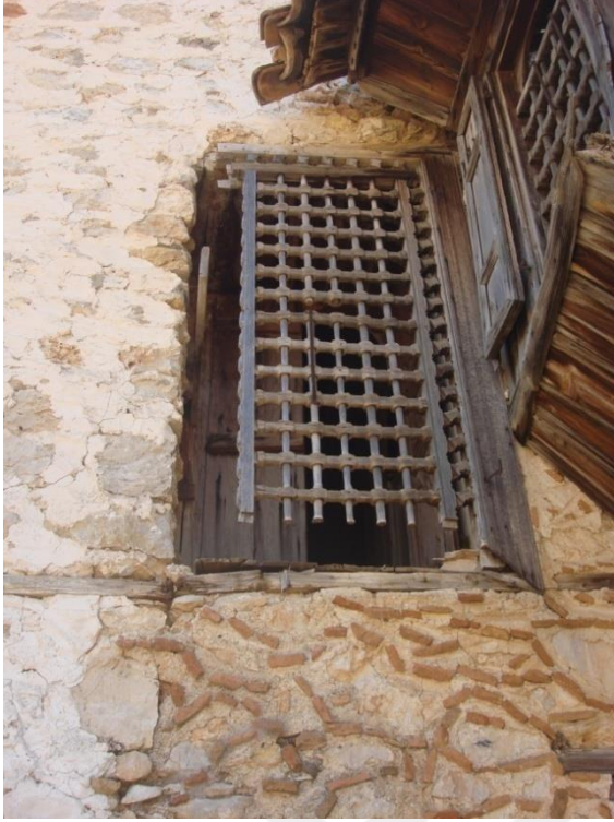
Resim 4.8. Oda mekânın özgün ahşap kafesi
