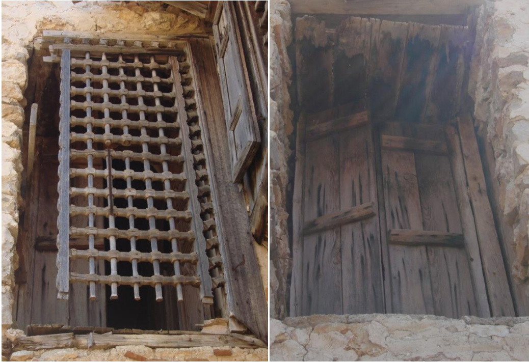
Resim 5.5. Mehmet Duruk konutu yeri, izi, boyutu malzemesi belli olan güneybatı cephesine açılan pencere görünümü
