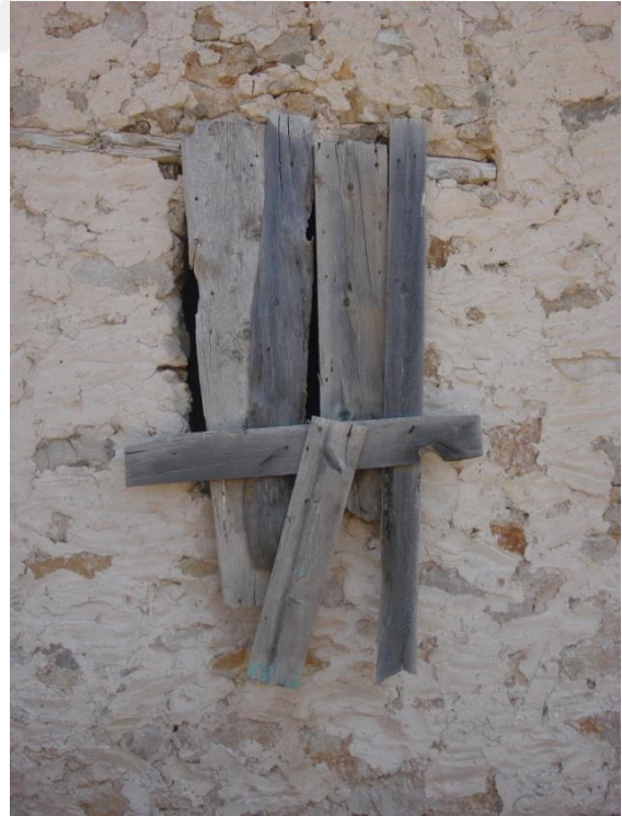
Resim 4.11. Depo mekânın pencere boşluğu
