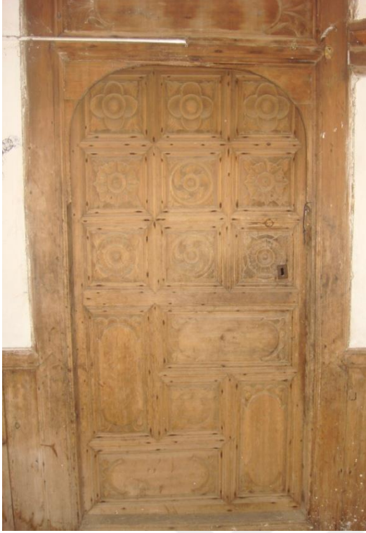
Resim 4.56. Oda mekânına açılan bezemeli ahşap kapılar
