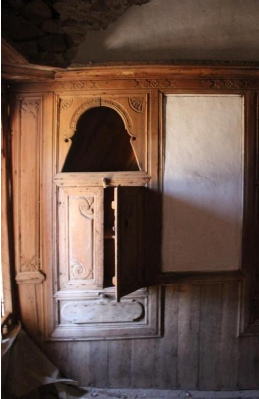
Resim 4.75. Oda kuzeybatı duvarındaki özgün ahşap nişler
