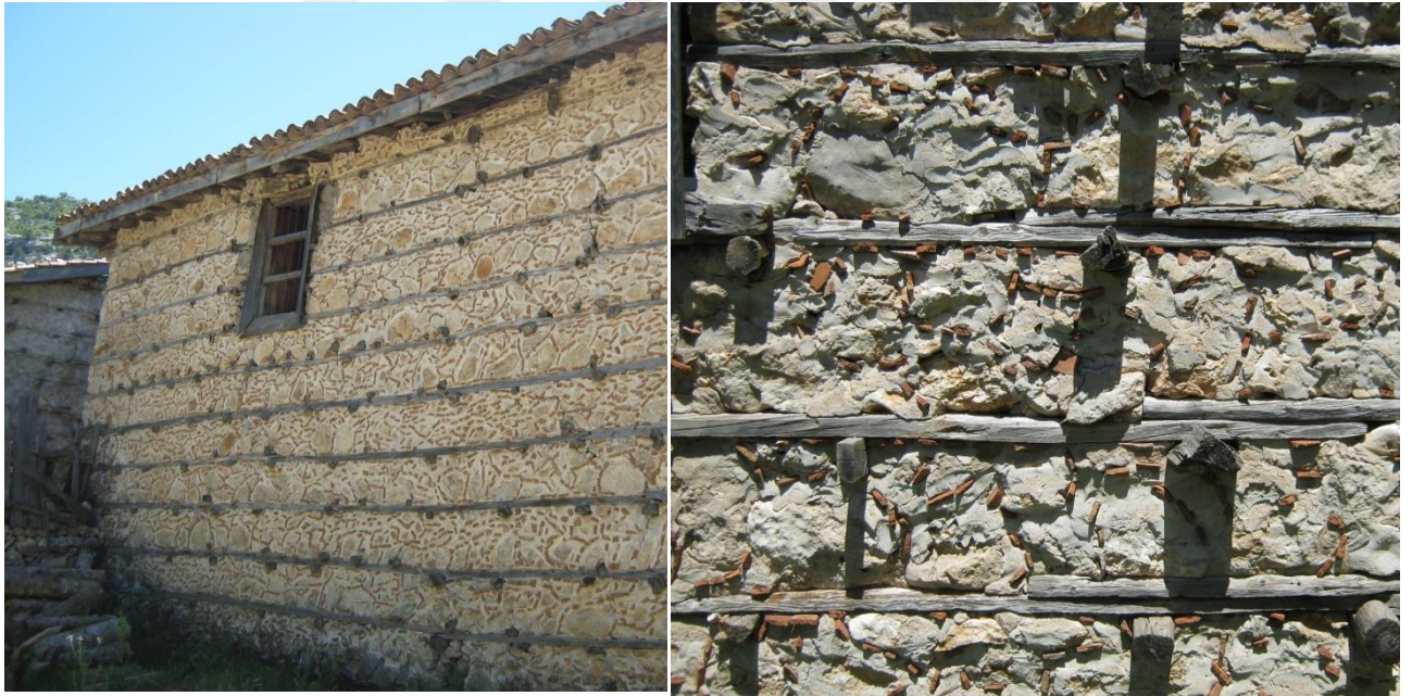
Resim 2.58. Taş duvarda “çivileme” örneği
