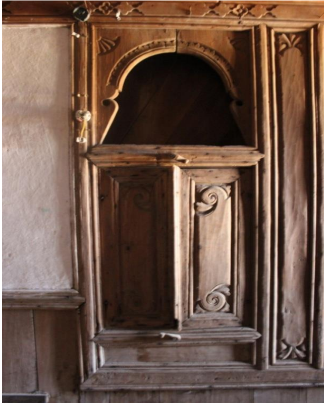
Resim 4.73. Oda güneybatı duvarındaki özgün ahşap nişler
