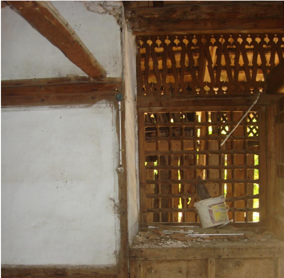
Resim 4.59. Ahşap kafesli bölücü duvar görünümü
