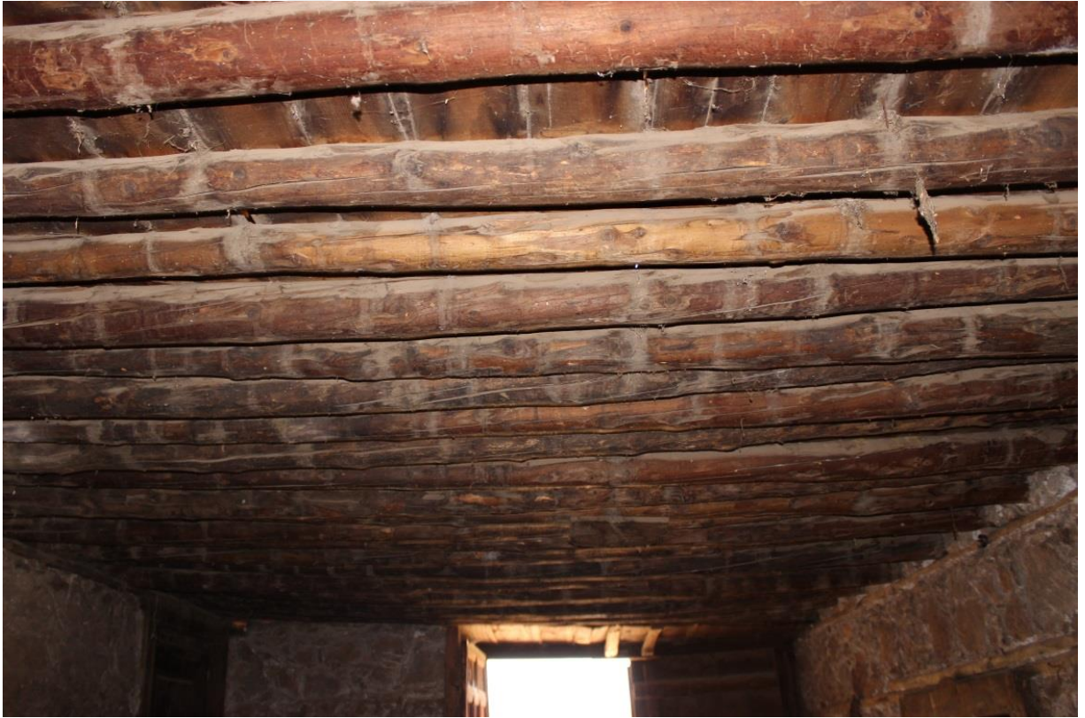
Resim 4.27. Ahşap döşeme kirişleri görünümü
