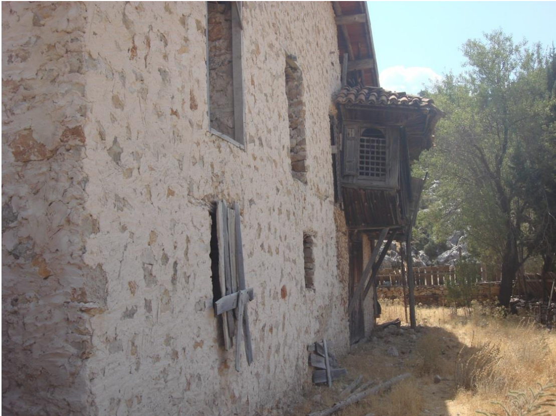
Resim 4.104. Çıkmayı taşıyan eli böğründeler
