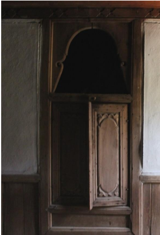
Resim 4.92. Oda mekânındaki özgün ahşap nişler
