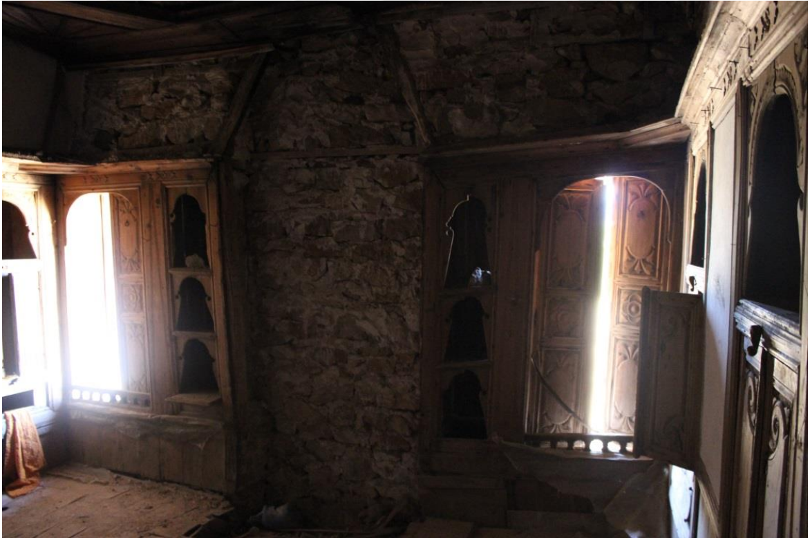
Resim 4.69. Oda mekânındaki pencereler ve ocak boşluğu
