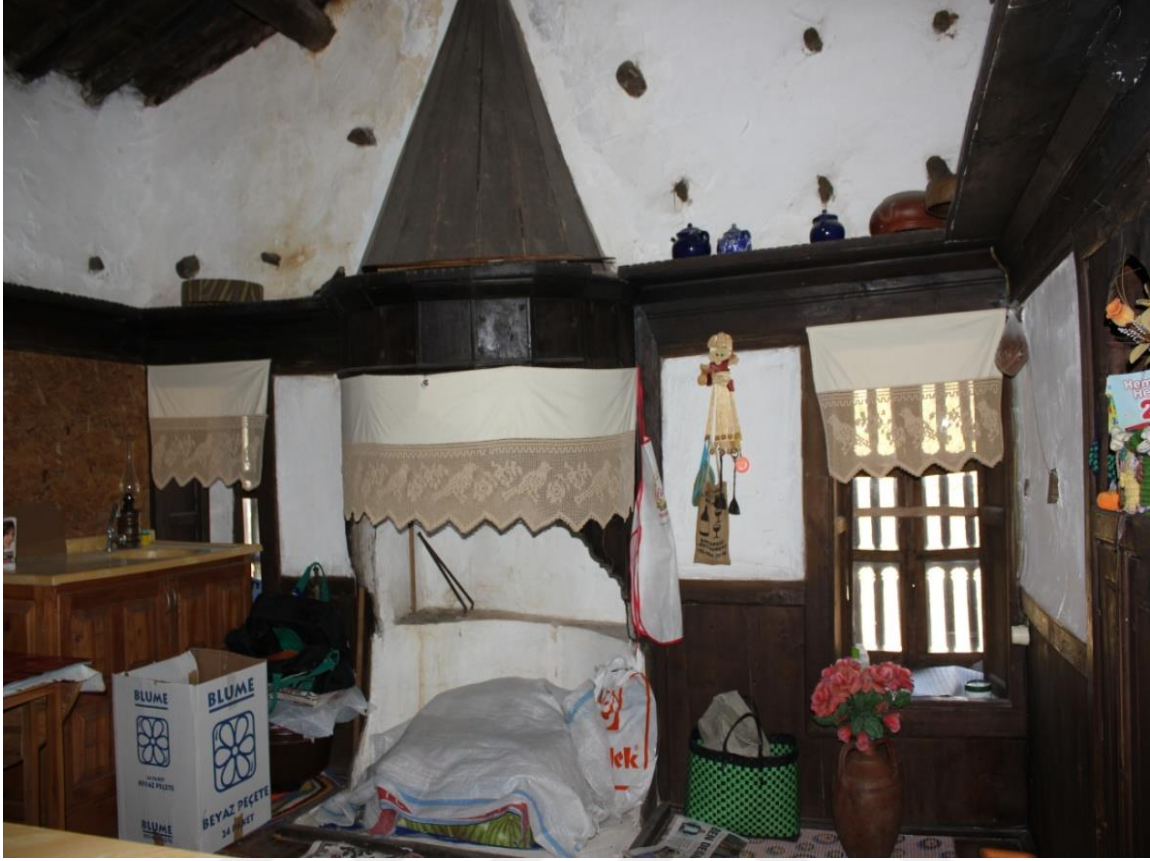
Resim 2.59. Duvar yüzeyindeki sıva kaplaması (Karayazı, 2015)
