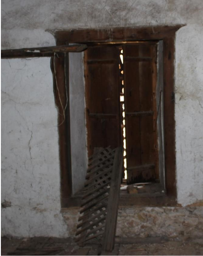
Resim 4.97. Oda mekânındaki dıştan kafesli içten kepenkli pencere
