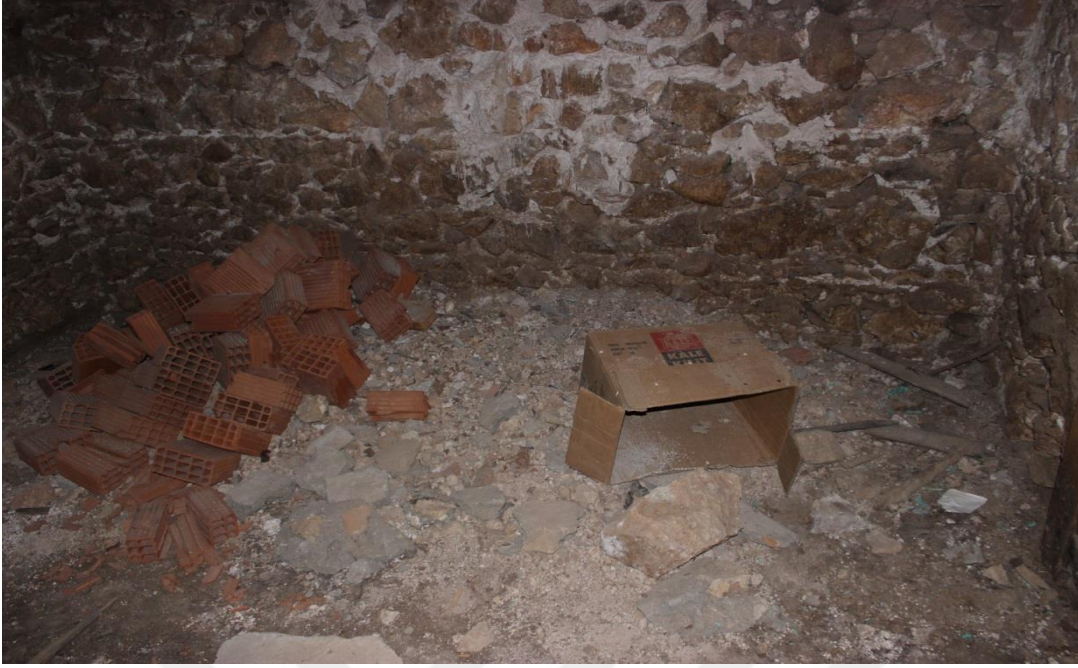
Resim 4.140. Çimento esaslı sıva uygulaması
