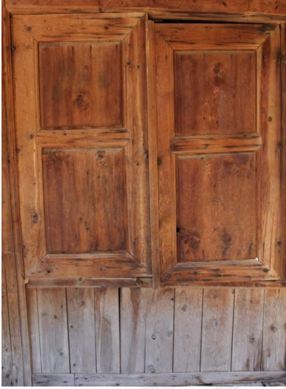
Resim 4.108. Kafesönü mekânındaki ahşap dolap
