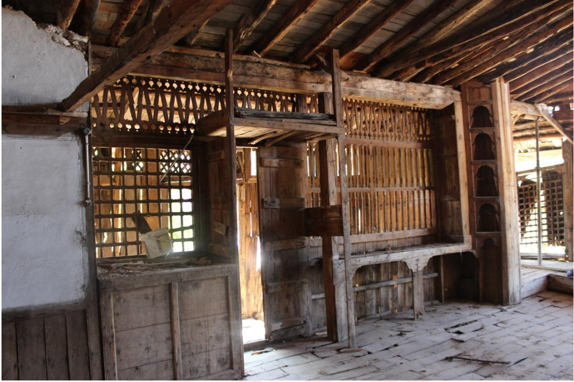
Resim 4.145. Zemin ahşap malzemede sehim
