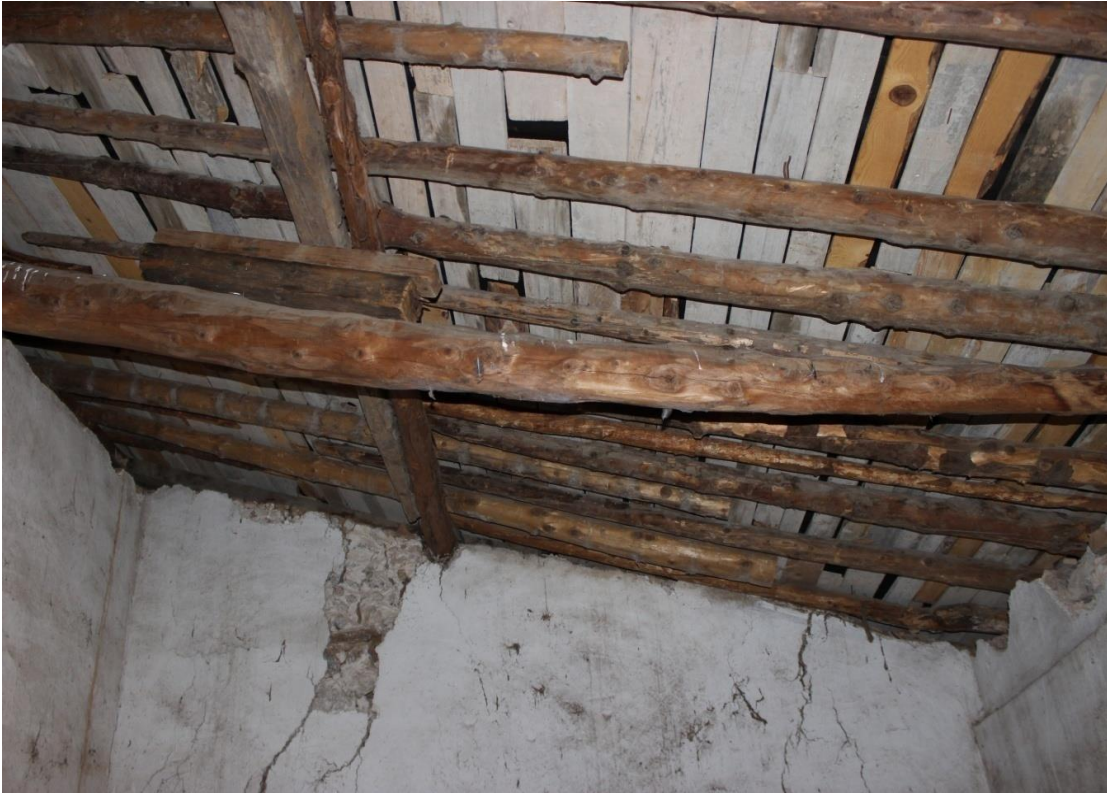
Resim 4.99. Oda mekânındaki tavan görünümü
