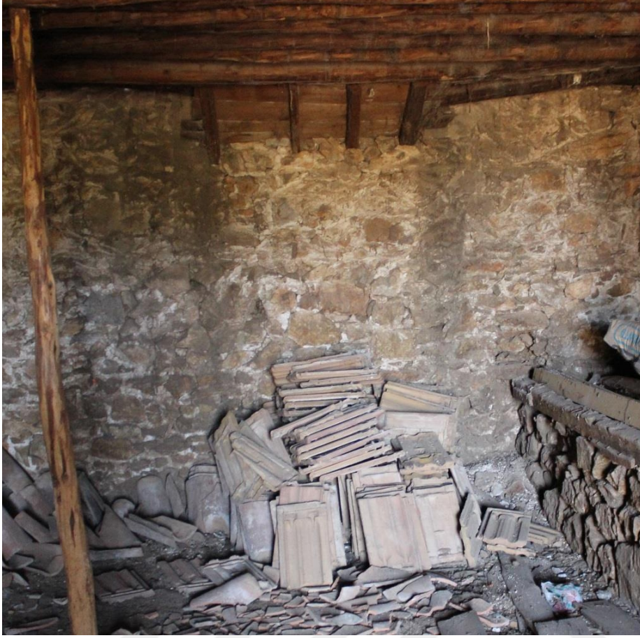
Resim 4.30. Evöğün mekânı ahşap dikme görünümü
