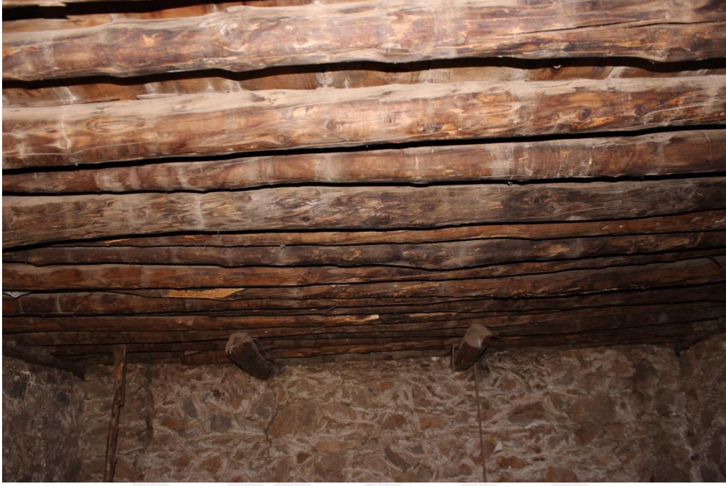
Resim 4.122. Döşemeyi taşıyan ahşap kirişler
