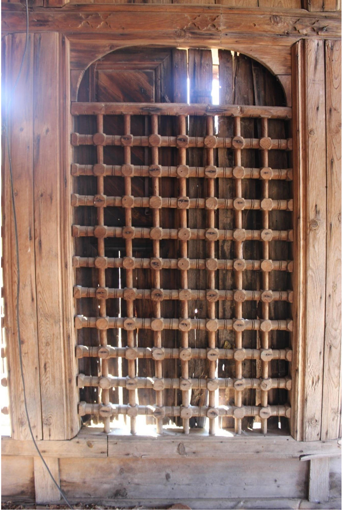
Resim 4.105. Kafesönü mekânındaki ahşap pencere
