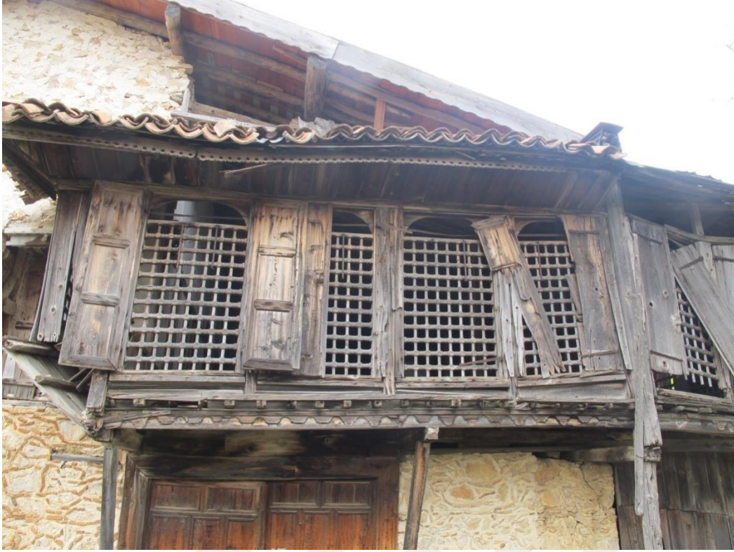
Resim 4.6. Çıkmayı taşıyan eli böğründeler ve ahşap dikme
