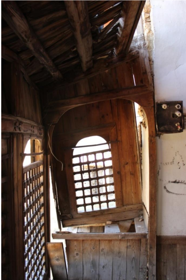
Resim 4.143. Sonradan eklenen tesisat malzemeleri
