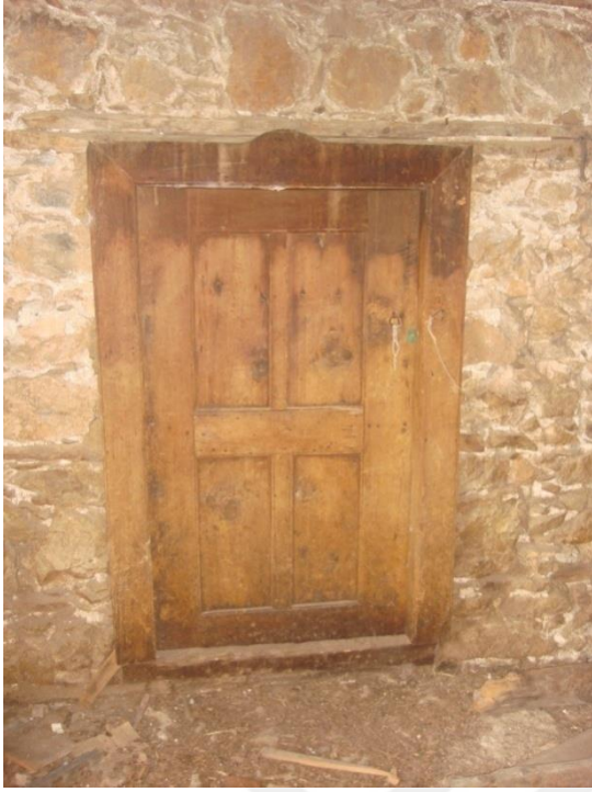
Resim 4.25. Depo mekânına açılan kapı
