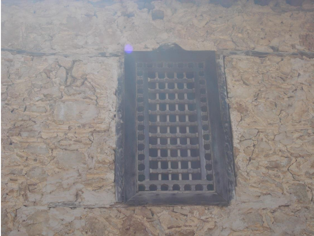
Resim 4.15. Oda mekânının içten kepenkli dıştan kafesli penceresi
