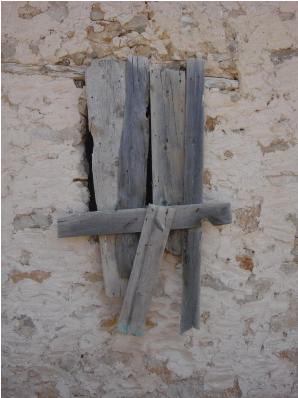
Resim 4.38. Depo mekânındaki pencere boşluğu
