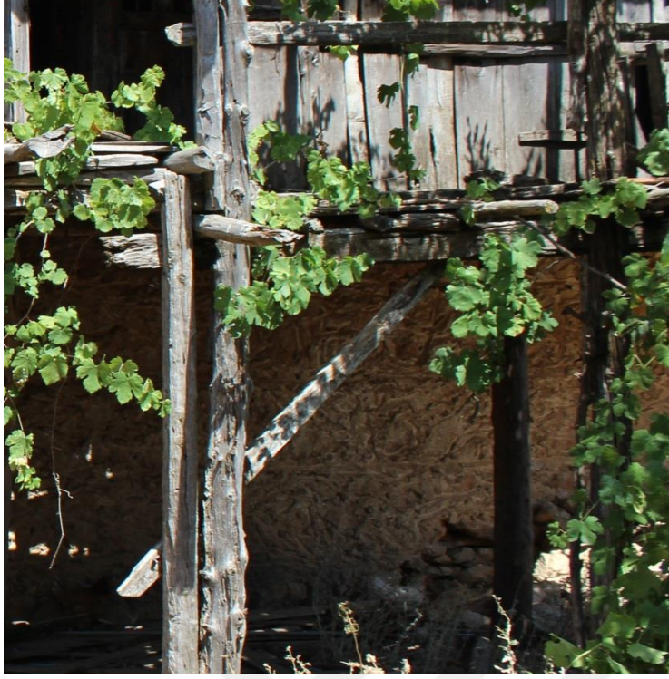
Resim 4.142. Ahşap destek elemanları
