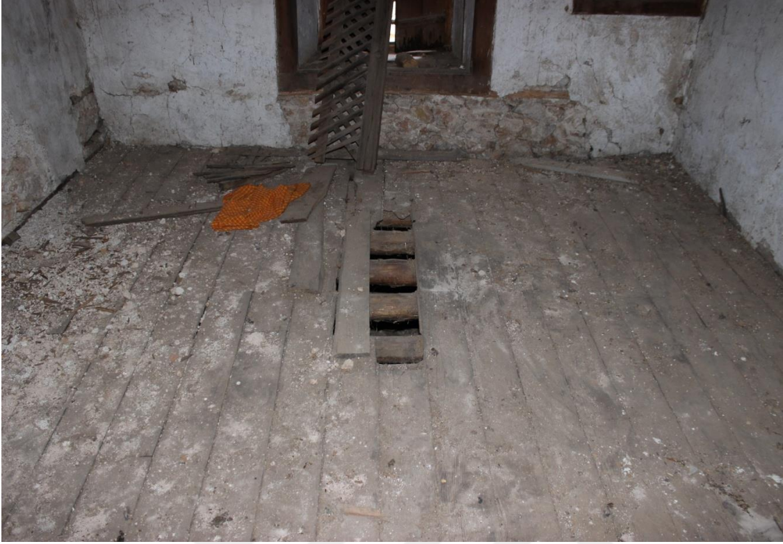
Resim 4.100. Oda mekânındaki döşemenin görünümü
