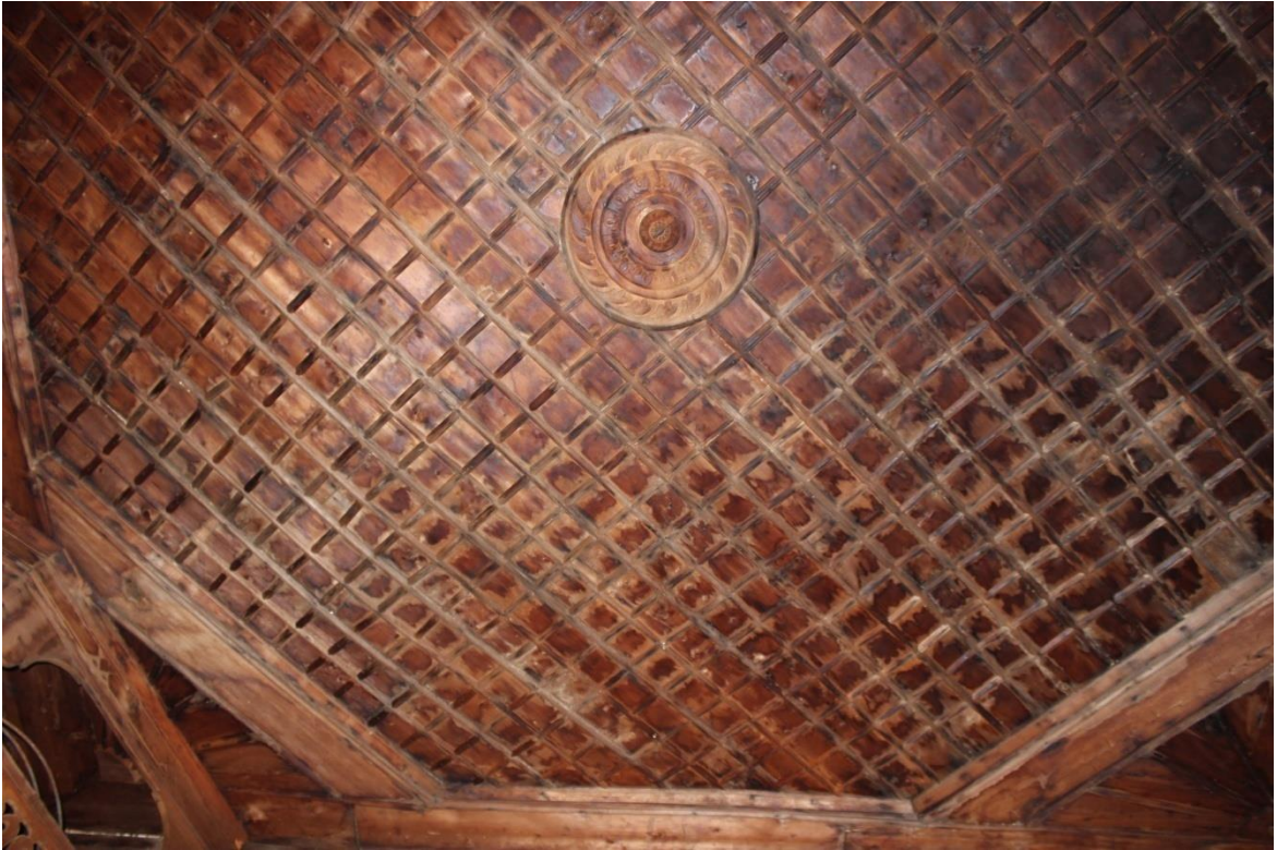
Resim 4.71. Oda mekânındaki tavan görünümü
