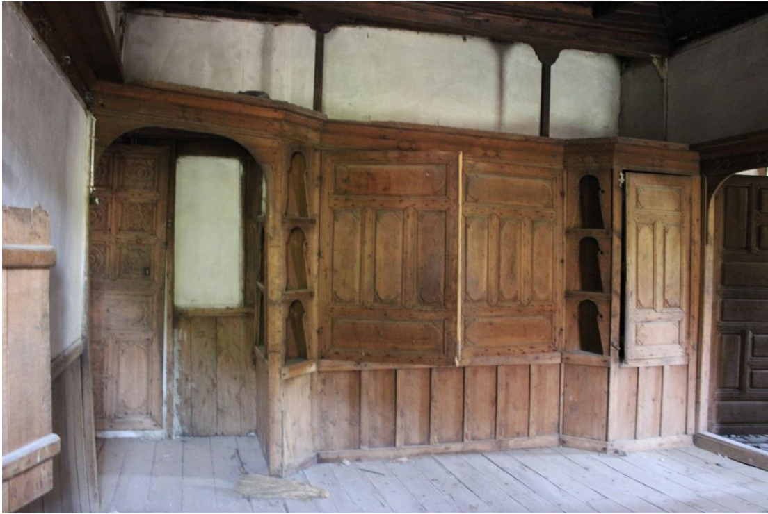
Resim 4.96. Oda mekânındaki sergen görünümü
