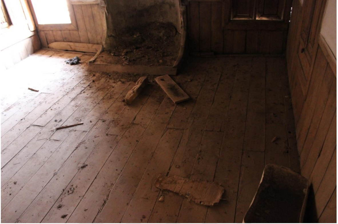
Resim 4.89. Oda mekânındaki zemin döşemesi
