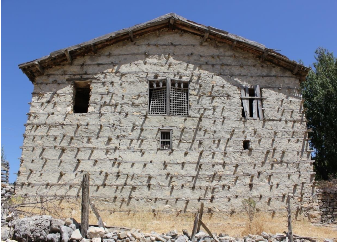
Resim 2.52. Akseki konutunda zemin kat penceresi
