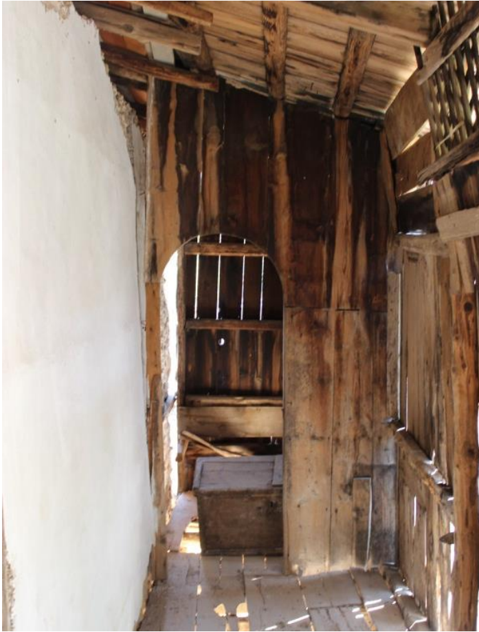
Resim 4.112. Hela mekânına açılan kapı boşluğu
