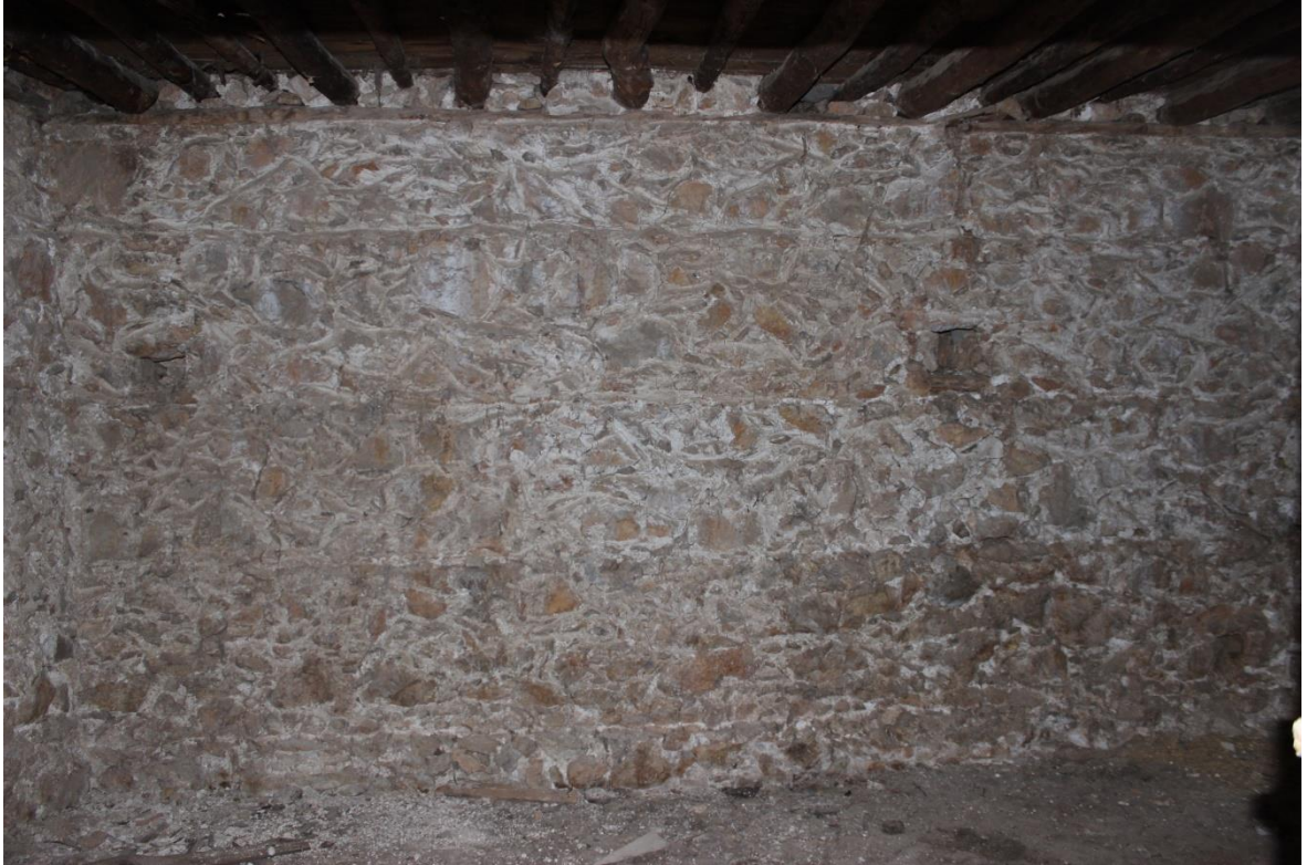
Resim 4.40. Depo mekânın döşeme görünümü
