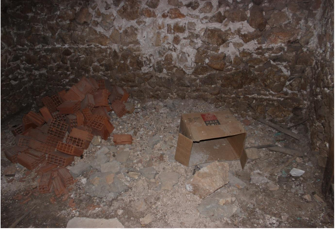
Resim 4.34. Depo mekânı zemin görünümü
