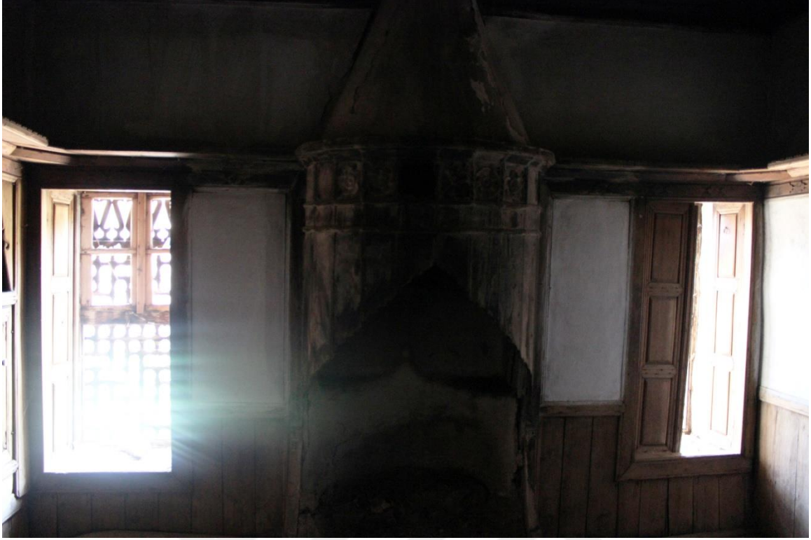
Resim 4.22. Oda mekânın dışarı açılan pencereleri
