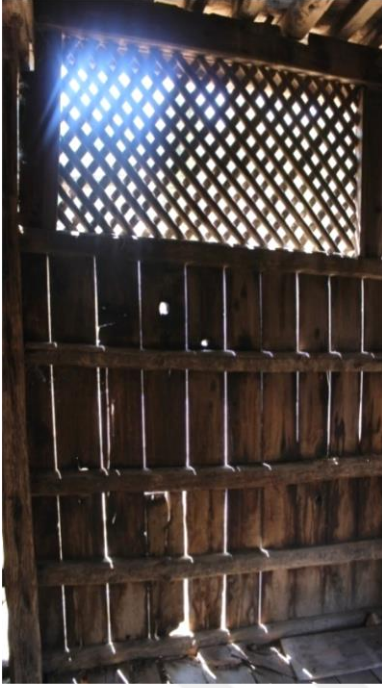
Resim 4.52. Peyke mekânındaki sabit ahşap kafesli pencere görünümü
