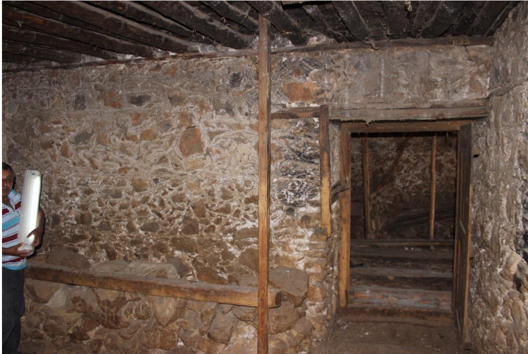
Resim 4.24. Ağıl mekânına açılan ahşap kapı
