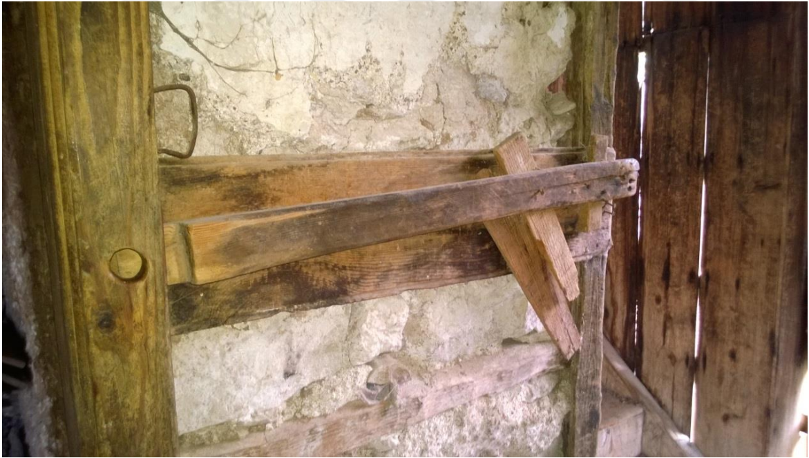
Resim 4.128. Özgün ahşap kilit sistemi
