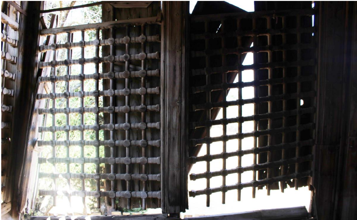
Resim 4.144. Ahşap kapaklarda deformasyon
