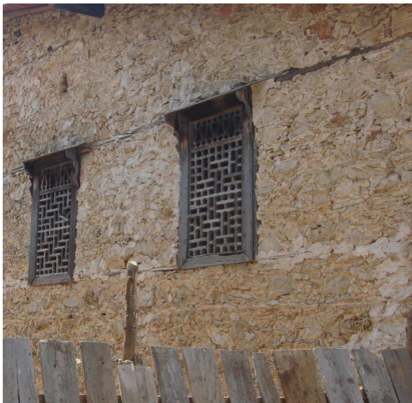
Resim 4.126. Özgün ahşap güneşlikler
