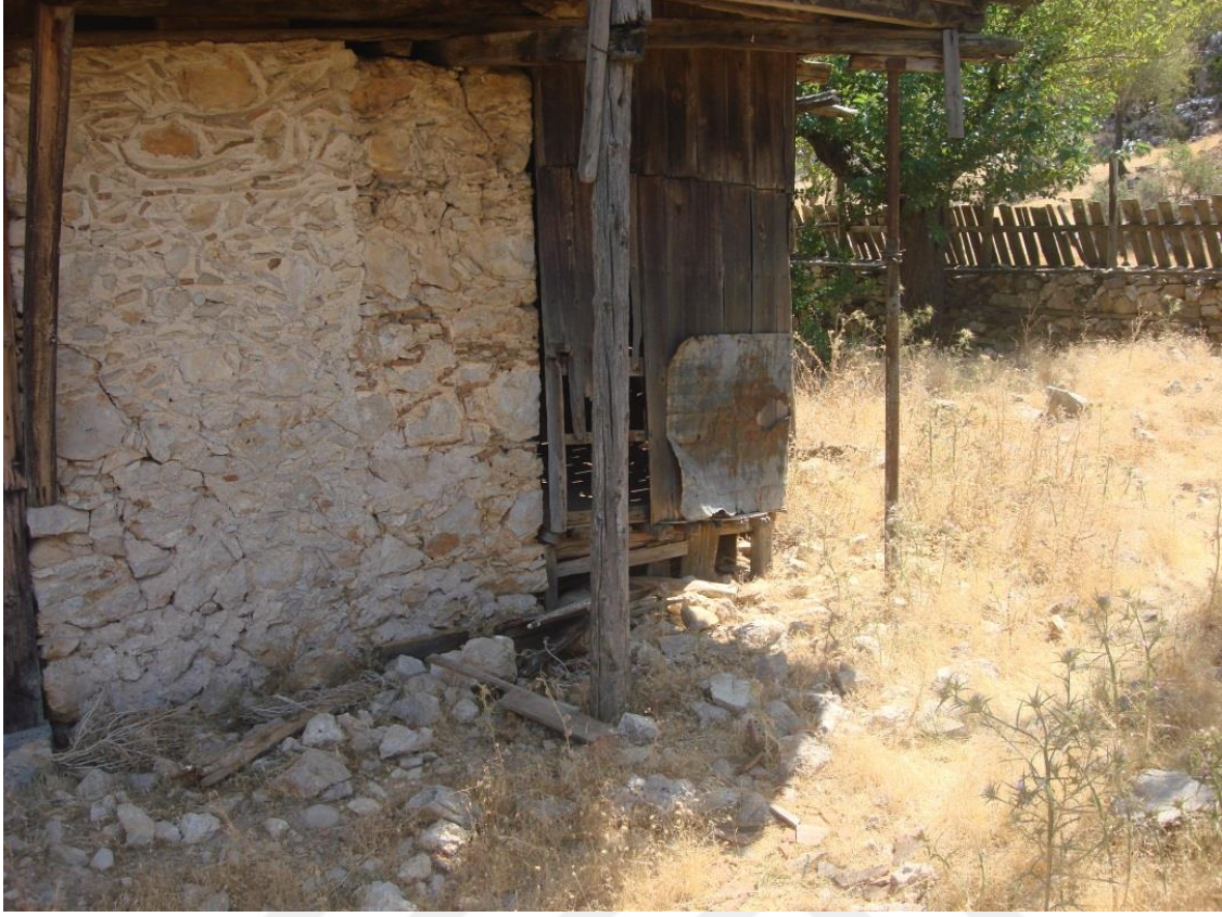
Resim 4.103. Çıkmayı taşıyan ahşap dikme
