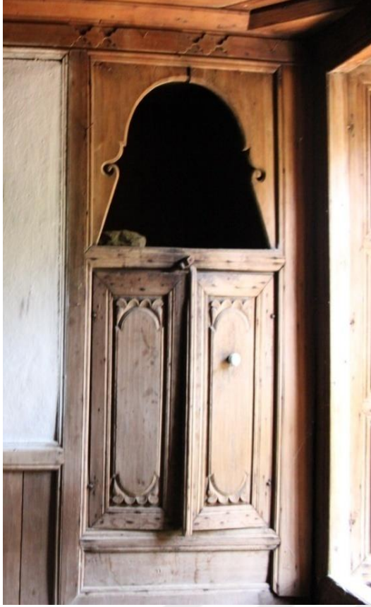
Resim 4.91. Oda mekânındaki özgün ahşap nişler
