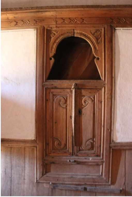
Resim 4.76. Oda kuzeybatı duvarındaki özgün ahşap nişler
