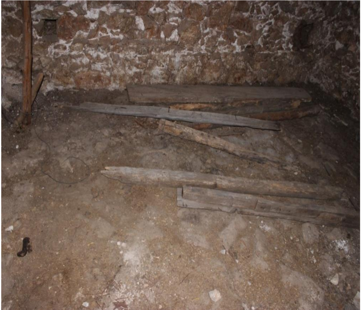
Resim 4.121. Mehmet Duruk evi zemin malzemesi
