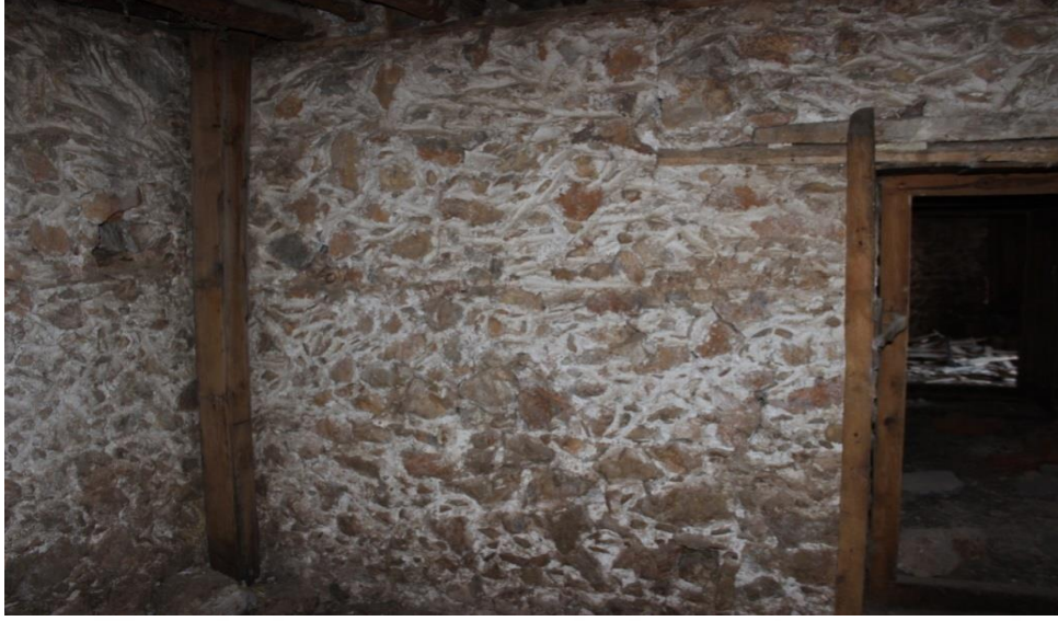
Resim 4.41. Depo mekânındaki ahşap oluk
