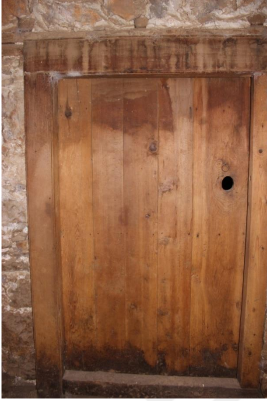
Resim 4.31. Depo mekânı ahşap kapısı
