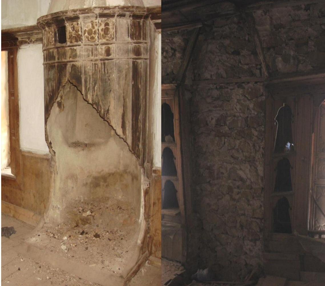
Resim 5.3. Mehmet Duruk konutu yeri, izi, boyutu malzemesi belli olan ocak görünümü
