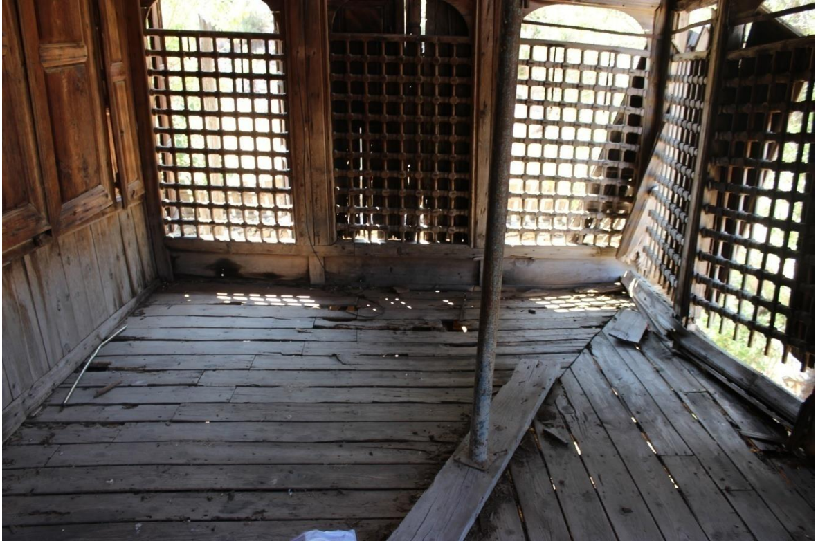
Resim 4.107. Kafesönü mekânın zeminin görünümü
