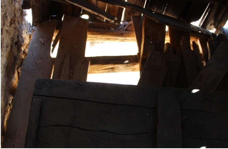
Resim 4.117. Hela mekânının döşemesinin görünümü
