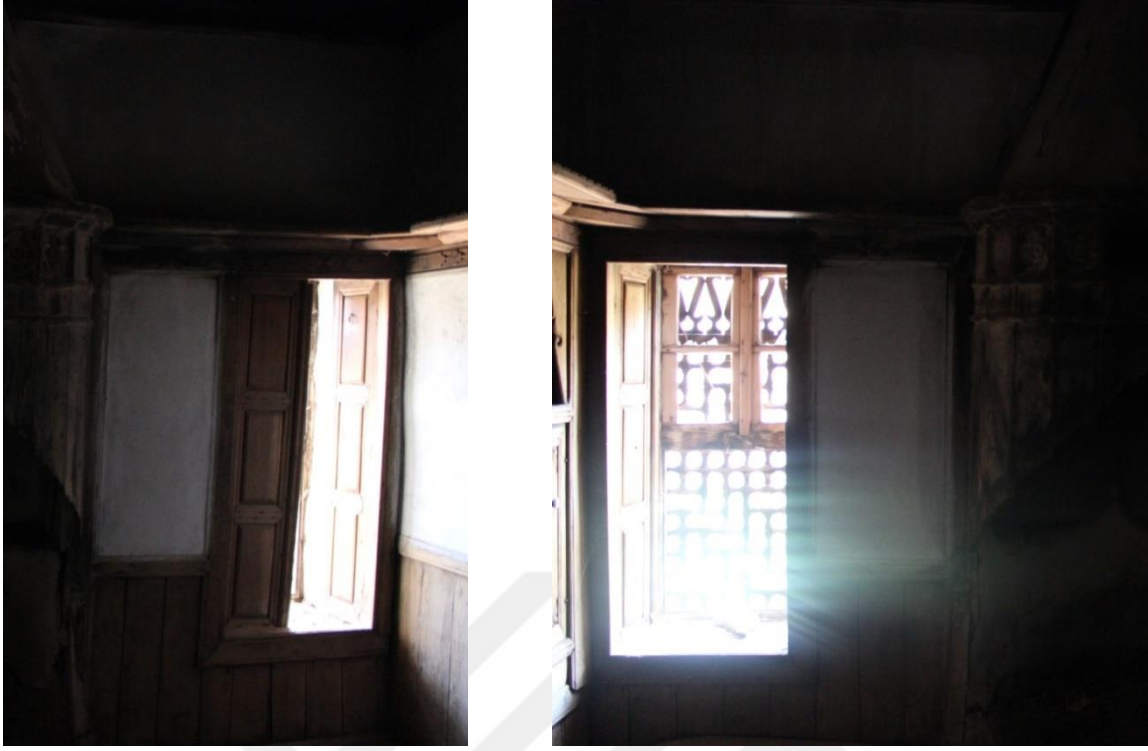
Resim 4.87. Oda mekânındaki dıştan kafesli içten kepenkli pencereler
