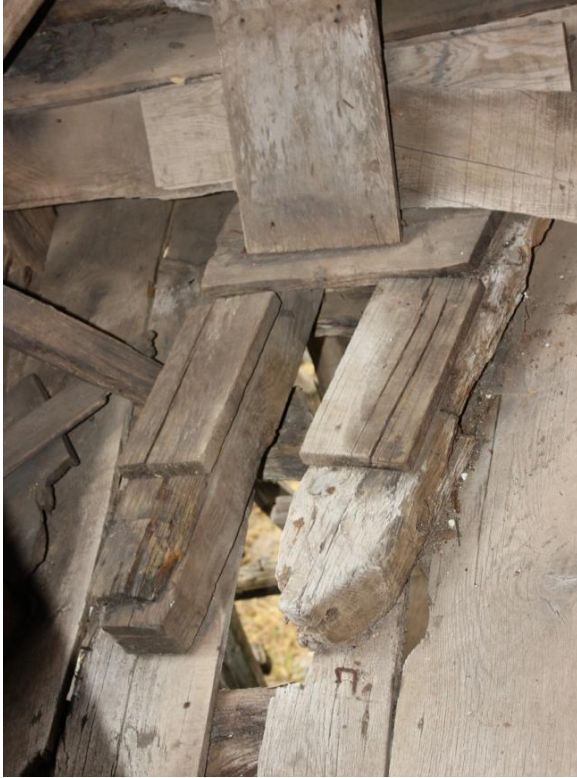
Resim 2.22. Bucakalan köyü hela görünümü
