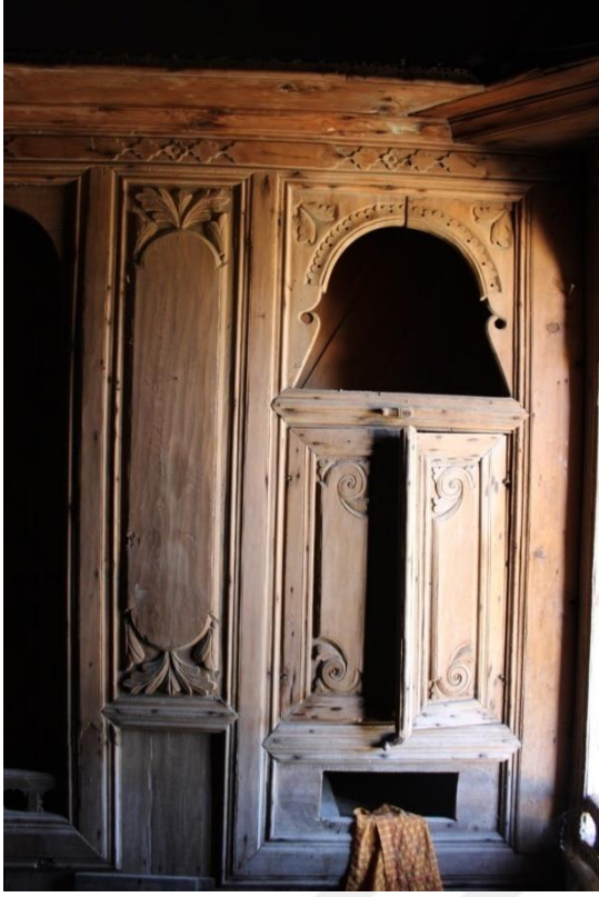
Resim 4.74. Oda güneybatı duvarındaki özgün ahşap nişler
