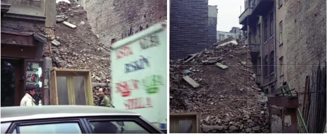
Şekil 4. 4 Muhsin Bey (Y. Turgul, 1987) Beyoğlu yıkım çalışmaları 3
