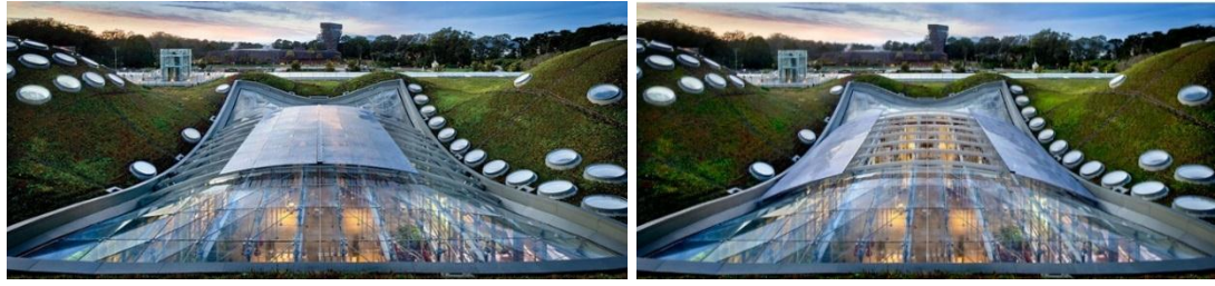
Şekil 76. Yeşil çatıdaki ayarlanabilir açıklıklar (California Academy of Science, 2016)
