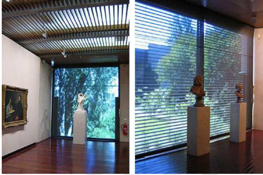
Şekil 63. Do Chiado Müzesi (Lisbon) – Pencere ve Tavan Işıklıklarında Kullanılan Mekanik Panjur Sistemi (Oliveira ve Guedes, 2006)
