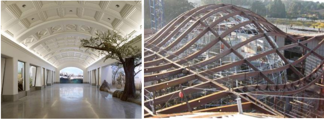
Şekil 71. California Bilim Müze'nin yapısında, yenilenmiş çelik kullanılmıştır. Eski binadan kalan sütunler Afrika Salonunda korunmuştur (Kociolek, 2005).
