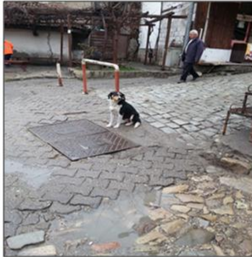
Şekil 25: Tarihi Çarşı'da çökmüş arnavut kaldırımları ve arnavut kaldırımlar ile uyumsuz döşeme örnekleri (Fotoğraf: Çiğdem BOGENÇ 2016).
