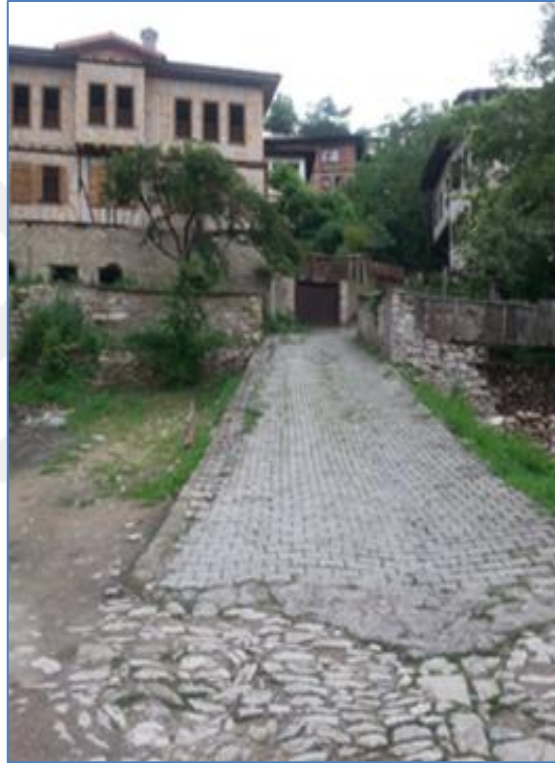
Şekil 23: Safranbolu Çarşı’da özgün taş doku ile uyumsuz yeni bir döşeme uygulaması (Fotoğraf: Çiğdem BOGENÇ 2016).
