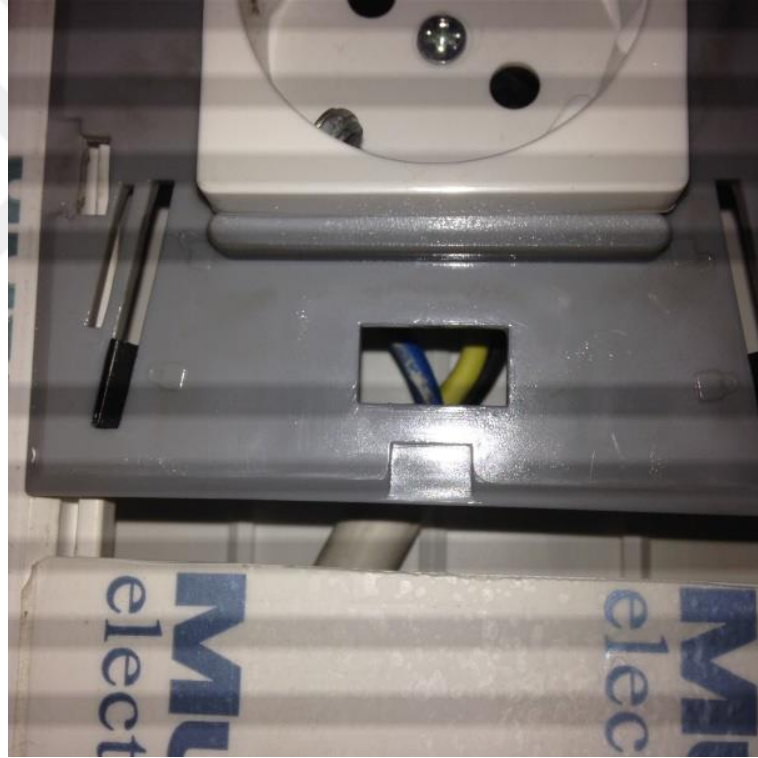
Şekil 6.7 Laboratuvardaki priz bağlantılarının kontrolü.
