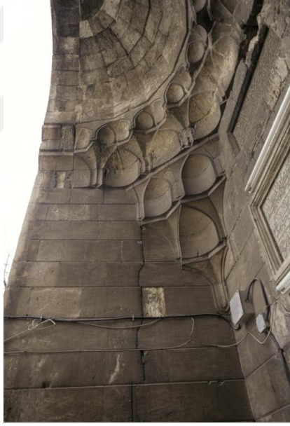
Şekil 1.2 Duvardan kubbeye geçiş örneği [5]
