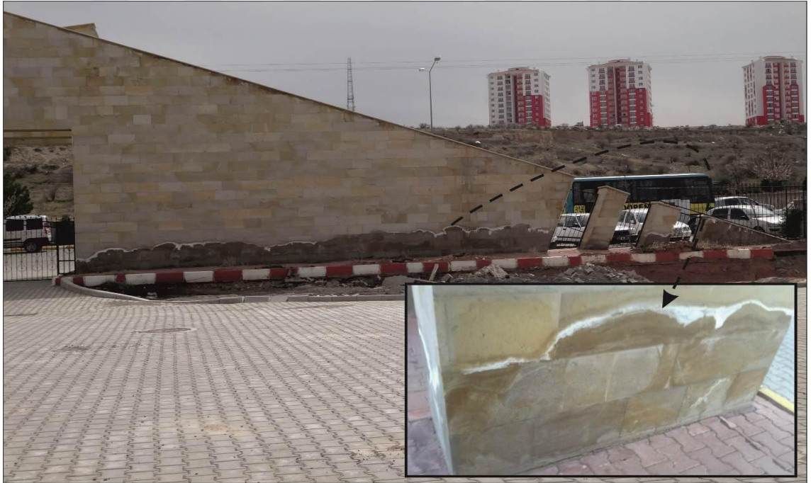
Resim 1.2. Nevşehir Bölgesinde kılcal su emme etkisiyle oluşan fiziksel bozunma
