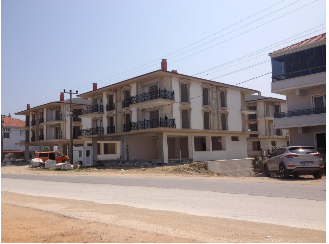
Foto 28: Yapımı Devam Eden Konutlar.
