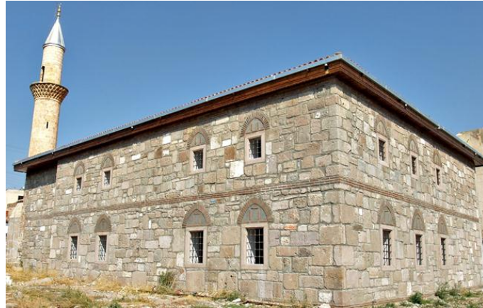
Resim 5.8. Bergama Emir Sultan Camii Rekonstr ksiyon Sonrası
