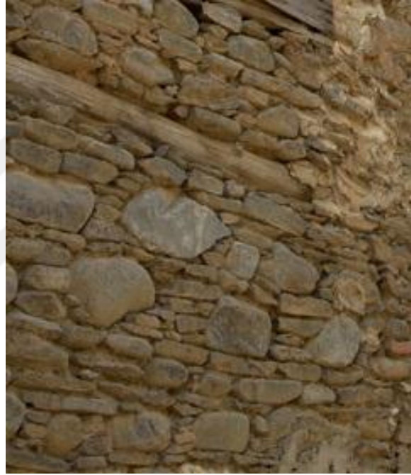
Resim 4.11. Kayrak Taşı Duvar Örgüsü
