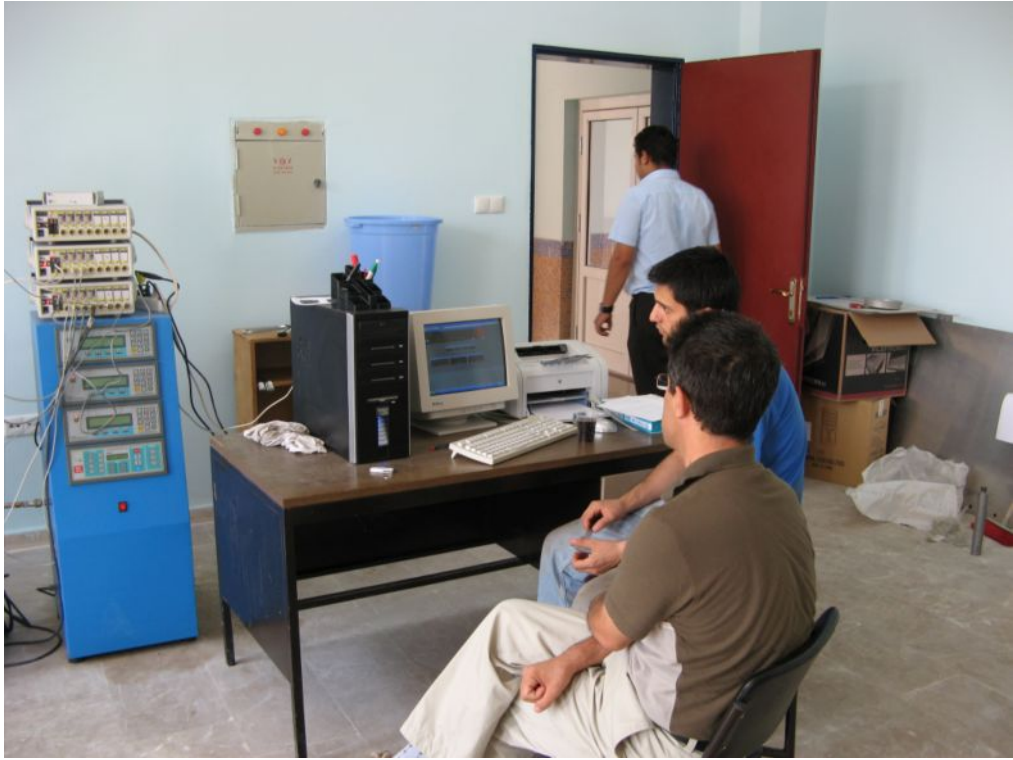
Şekil 5-21 Yük ve yer değıştirme okumalarını değerdendiren veri aktarım sistemi ve bilgisayar düzeneđi
