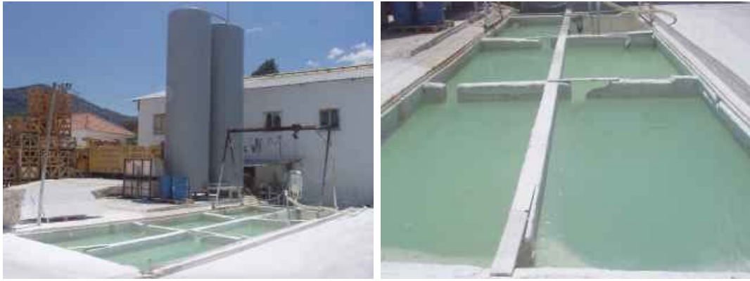
Şekil 2.7. Çökeltme havuzlarında yapılan arıtım
