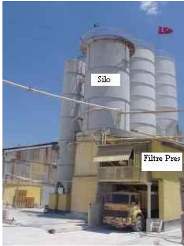
Şekil 2.8. Çökeltme tanklarında yapılan arıtım
