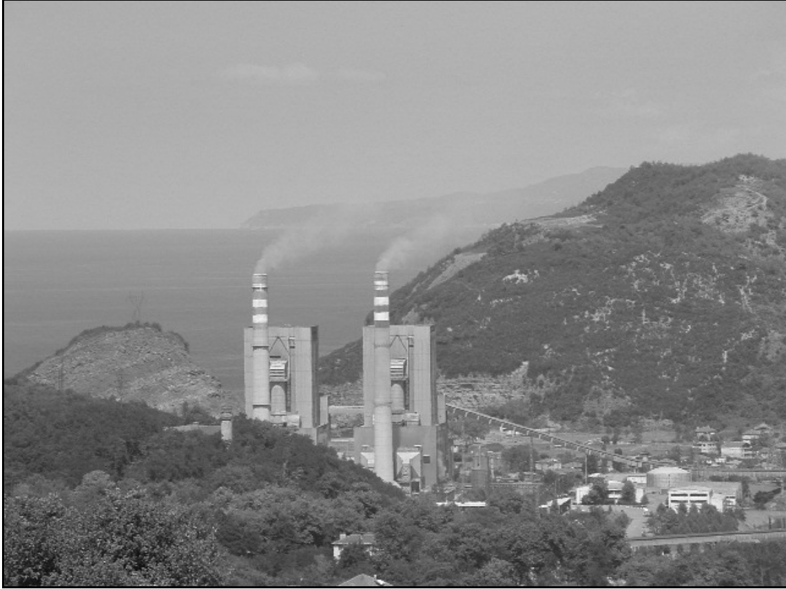
Şekil 5.5 Çatalağzı Termik Santrali.
