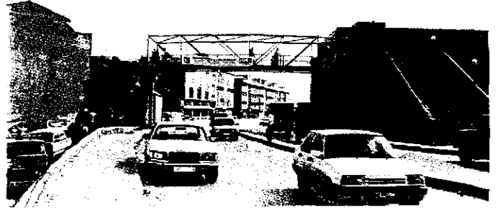
Terazidere Metro İstasyonu Üstgeçiti'nden bir görüntü.
