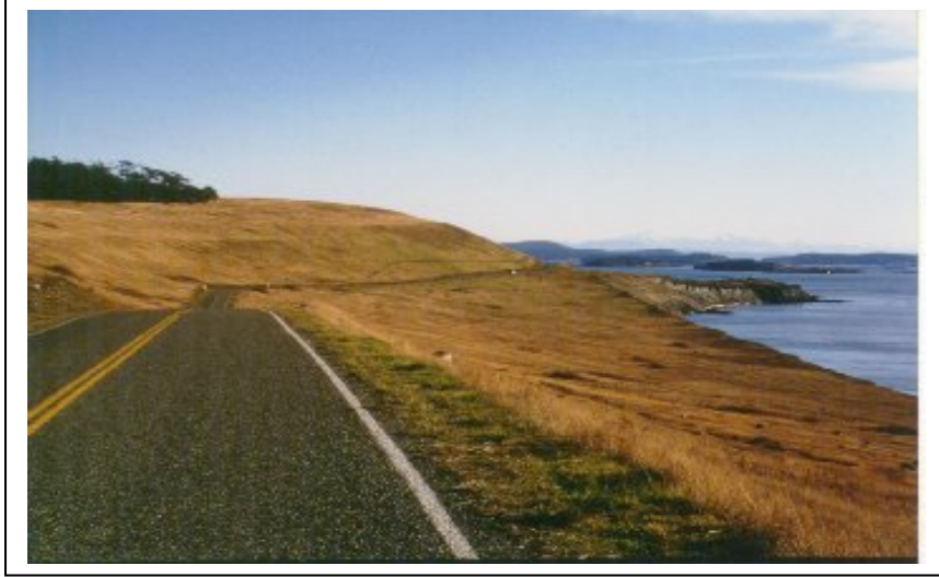
Şekil 2.19 : Kısa mesafeli ters eğimlerin kullanımı (Anonim, 1974)
