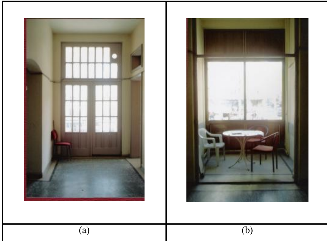
Şekil 5.30. (a) Öz Otel Koridoru İlk Hali (b) Öz Otel Koridoru Tadilatın Sonraki Hali
