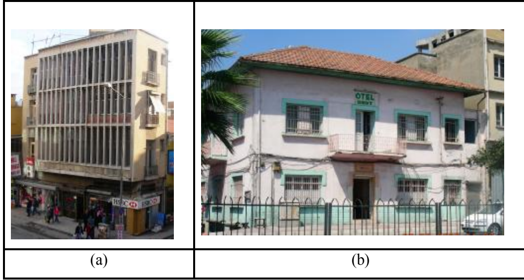
Şekil 5.13. (a) Ak Otel, (b) Umut Otel
