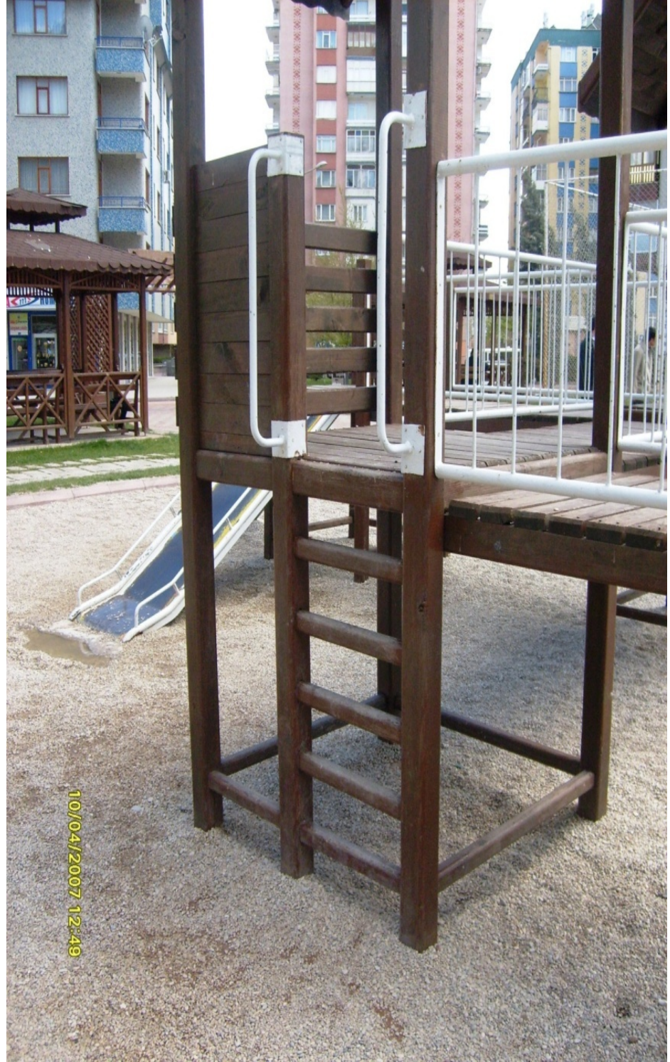
Şekil 4.39. Nenehatun parkında tırmanma merdiveni detayı (Orijinal 2007).
