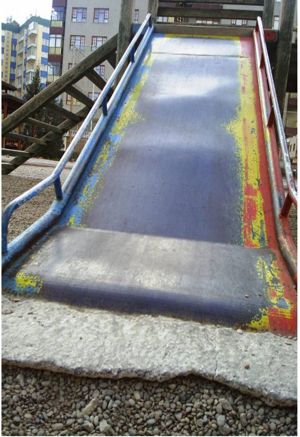
Şekil 4.34. Nenehatun parkında kum zeminin sıyrılması sonucu beton temeli açığa çıkmış kaydırak detayı (Orişinal 2007).
