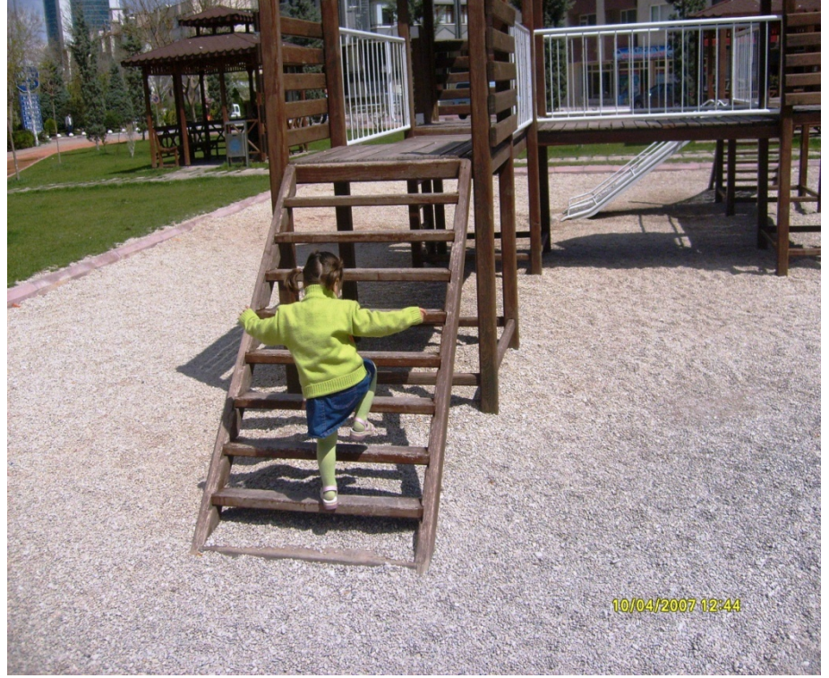
Şekil 4.53. Nenehatun parkında korkuluksuz merdiven detayı (Orijinal 2007).
