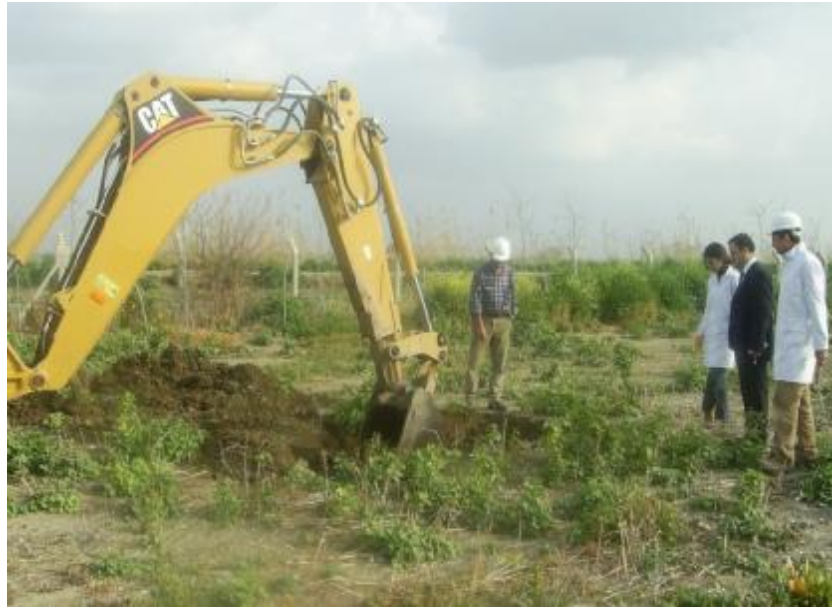
Şekil 3.2. Arazide Muayene Çukuru Açılması
