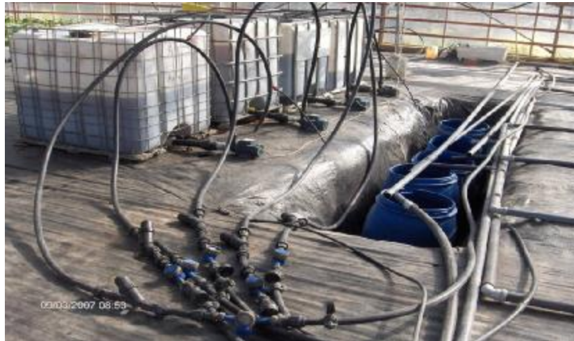
Resim 3.3. Denemede kullanılan her biri 1000 litre kapasiteli besin çözeltisi tankları ve her bir uygulamadan gelen drenaj çözeltilerinin toplandığı toprak altı seviyesine yerleştirilen drenaj tankları.
