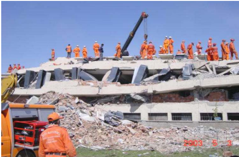
Şekil 2.4. Çeltiksuyu YİBO binası yıkılma görüntüsü (Bayülke vd 2004).
