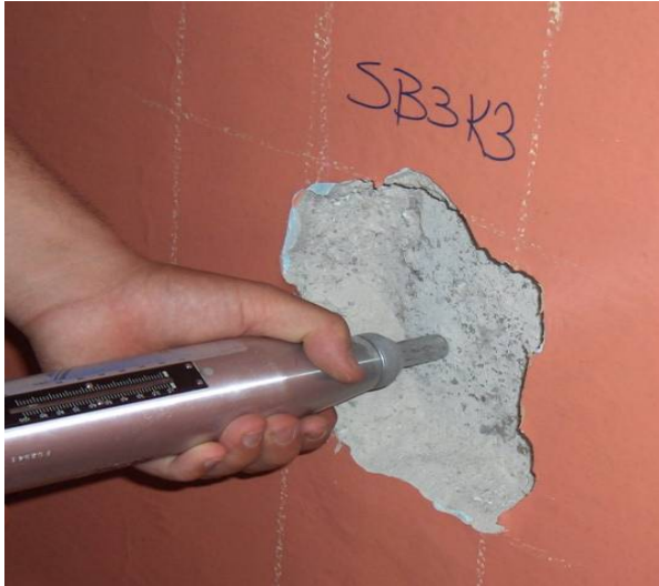
Şekil 5.13. Beton tabancası deneyi yapılışı
