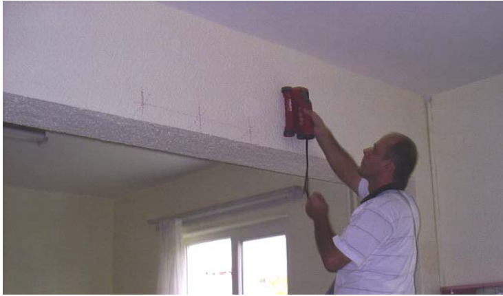
Şekil 5.16. Kirişlerde donatı taraması (Etriye aralığının belirlenmesi)
