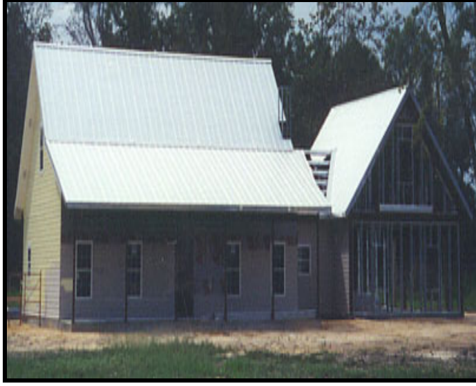
EK-4e Kaplamaların tamamlanması (Web İletisi 2).
