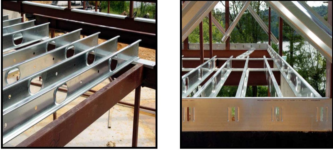
Şekil 5.29. Hafif çelik konstrüksiyon döşeme detayı (web iletisi 2).
