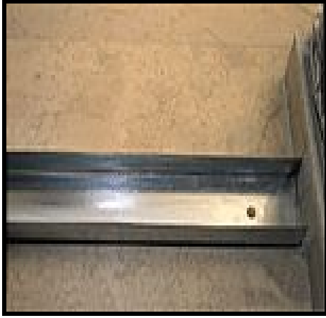
Şekil 5.14. U profili montajı (web iletisi 1).
