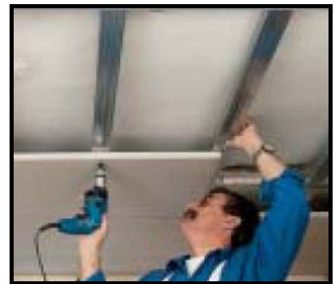
Şekil 5.33. Asma tavan montaj detayları (web iletisi 1).
