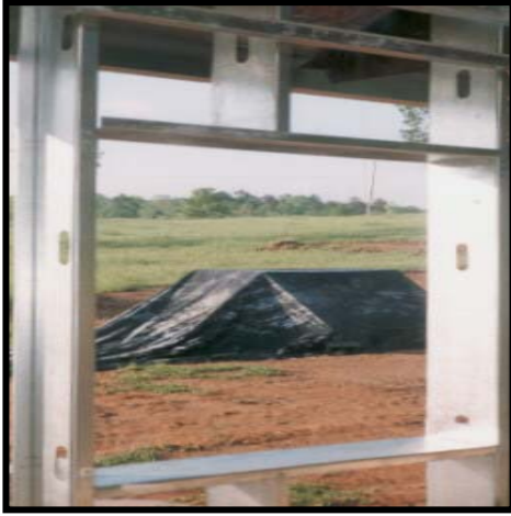
Şekil 5.7. Pencere boşluğunun oluşturulması (web iletisi 2).
