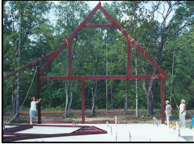
EK-4a Çelik makas ve kolonların montajı (Web İletisi 2).
