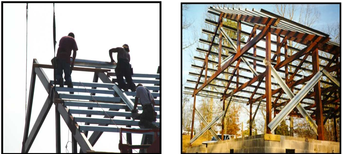
Şekil 5.41. C ve Z profillerinin çatı makaslarına yerleştirilmesi (web iletisi 2).
