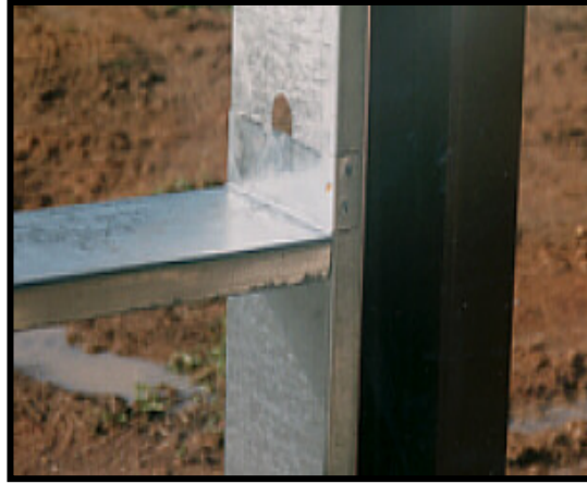
Şekil 5.6. C profilin diğer profile montajı (web iletisi 2)
