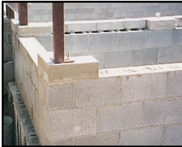
Şekil 5.5. Kolonların temel duvarı üzerine montajı ( web iletisi 2 ).
