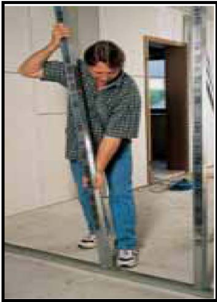
Şekil 5.16. U profili montajı ( web iletisi 1 ).
