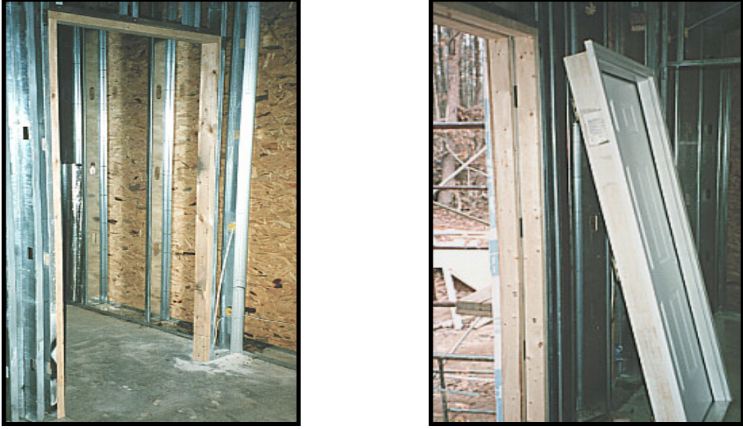
Şekil 5.8. Kapı boşluğunun oluşturulması ( web iletisi 2 ).
