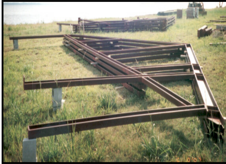
Şekil 5.39. Çatı makasının oluşturulması ( web iletisi 2 ).
