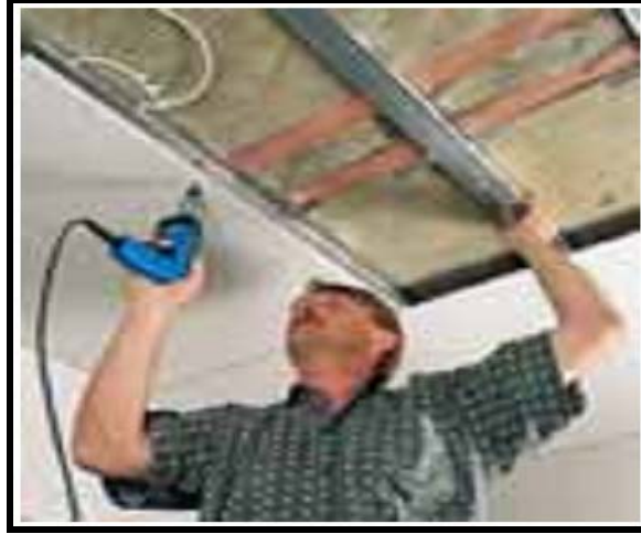
Şekil 5.30. Döşemelerde alçı plak uygulaması ( web iletisi 1 ).
