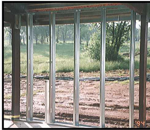
Şekil 5.3. Hafif çelik profillerin çerçevelerin arasına yerleştirilmesi ( web iletisi 2 ).
