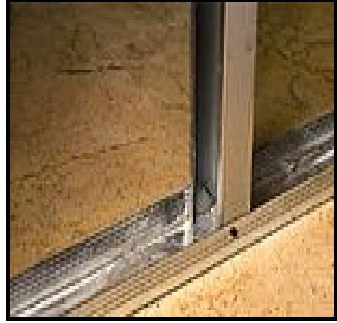
Şekil 5.15. C profillerin montajı (web iletisi 1).
