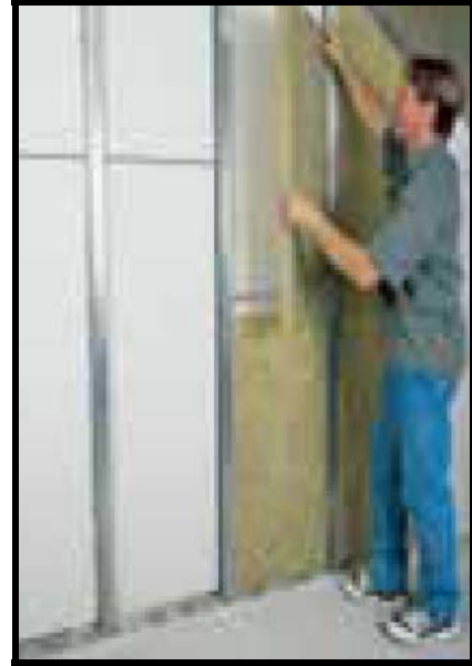
Şekil 5.17. Alçı plak ve taşıyıcı montajı ( web iletisi 1 ).
