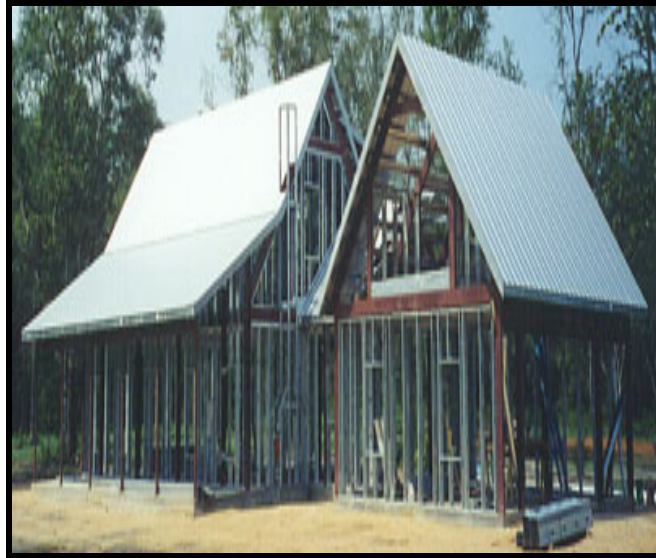
EK-4d Çelik konstrüksiyonun tamamlanması (Web İletisi 2).
