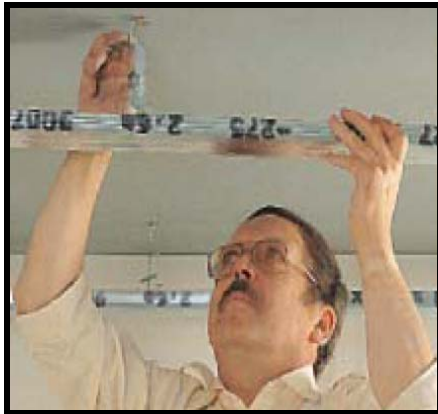
Şekil 5.33. Asma tavan montaj detayları (web iletisi 1).
