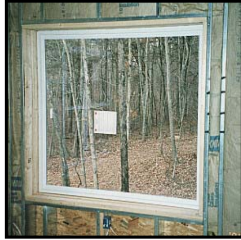
Şekil 5.7. Pencere boşluğunun oluşturulması (web iletisi 2).
