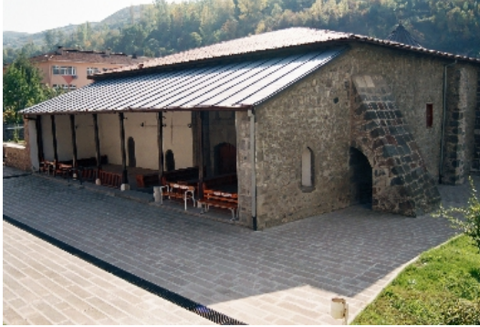
Şekil 3-17 Niksar Ulu Camii Görünümü
