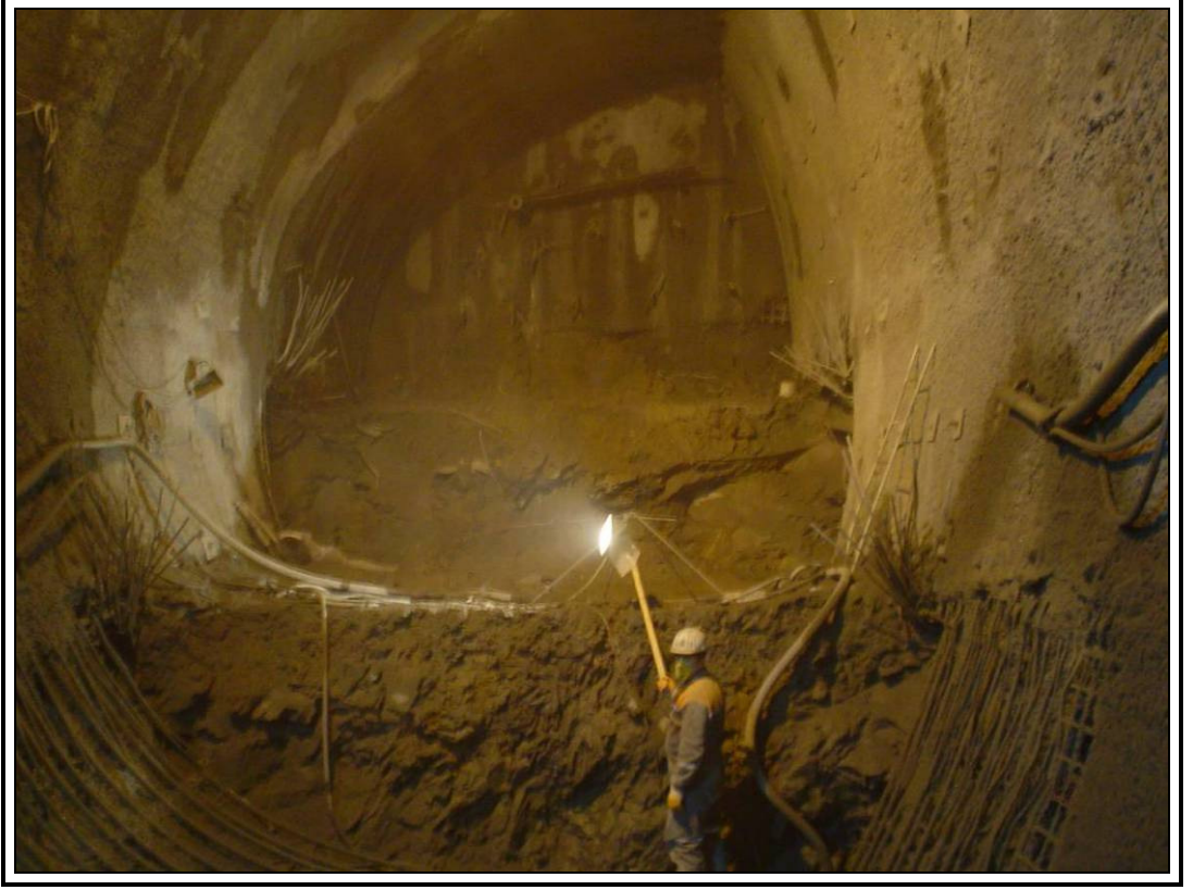
Şekil 6.4: M Tipi tünelde 1., 2. ve 3. kademe kazıları
