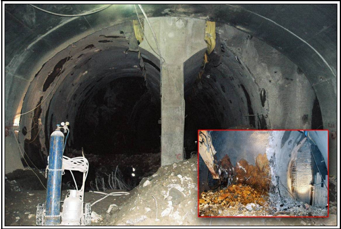
Şekil 6.12: Üçüncü aşama B1 kazısı ve eski destek sisteminin kırılması
