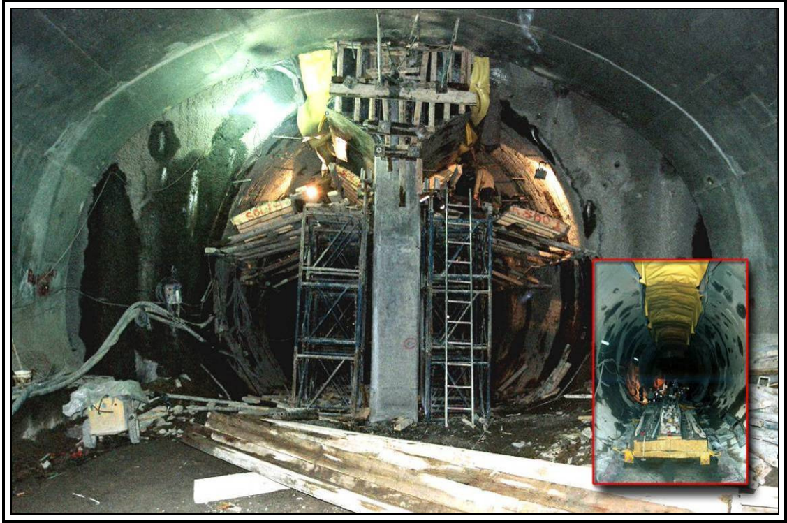
Şekil 6.11: KB1 Tüneli orta duvar imalatı
