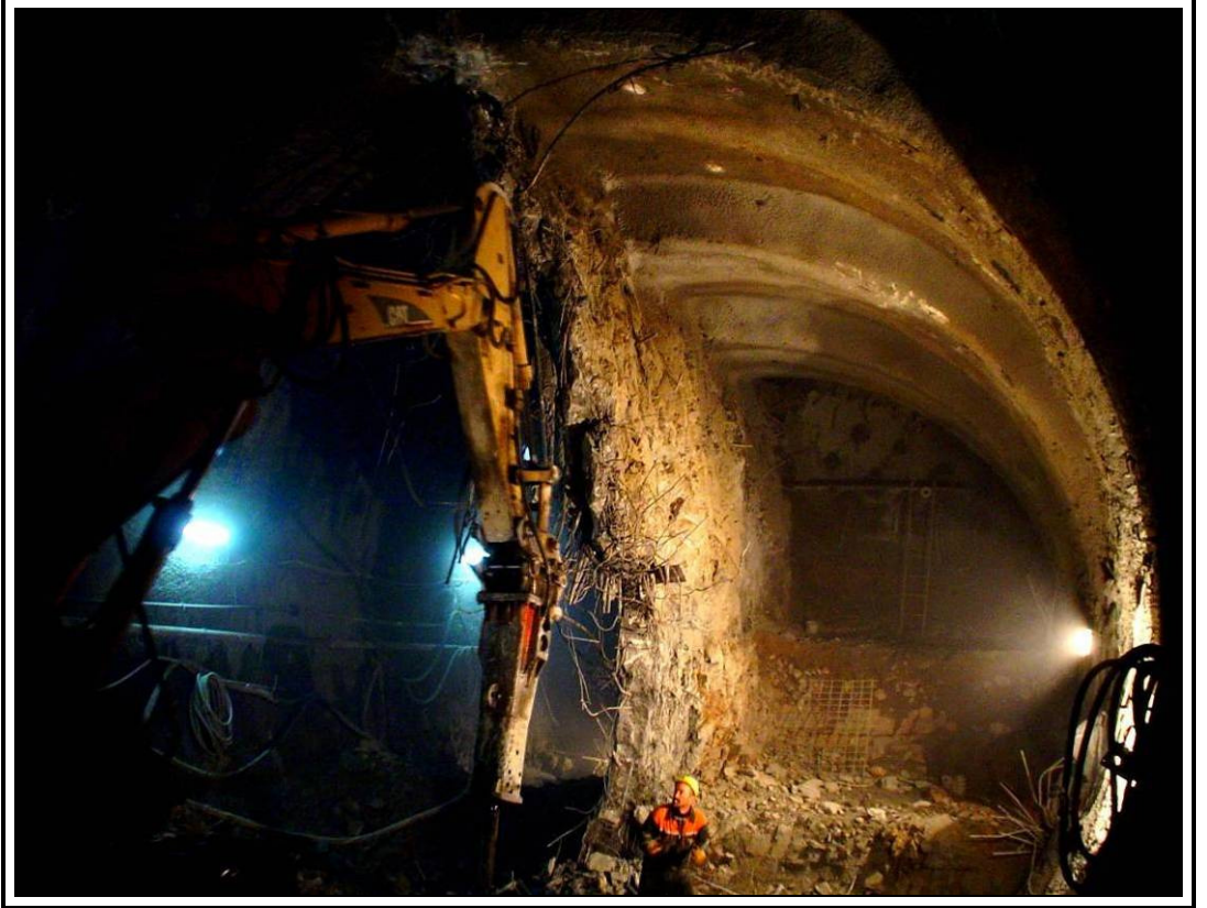
Şekil 6.5: L Tipi tünelde orta duvar uygulaması
