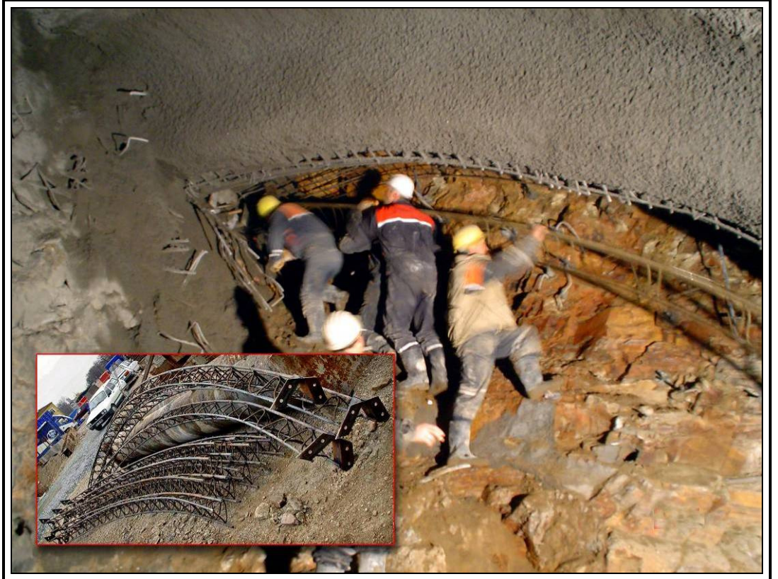
Şekil 6.3: Çelik iksa montajı
