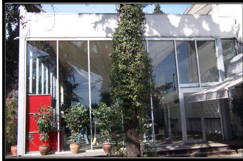
Şekil 3.11. İç Bahçeye Yapılan Kaçak Bir Portatif İlave Örneği
