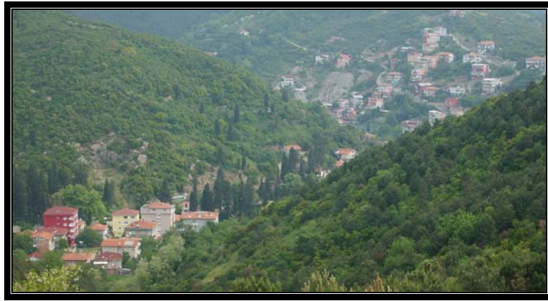
Şekil 3.25. Rumelikavağı'nda Hisseli Parsellere Yapılmış Kaçak Konutlar
