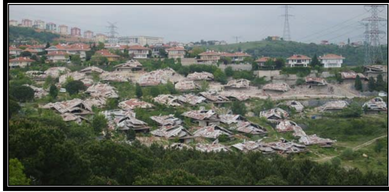
Şekil 3.33. Sarıyer Sırtlarında 47. Maddeye Göre Yapılıp, Yıkılmış Bir Site
