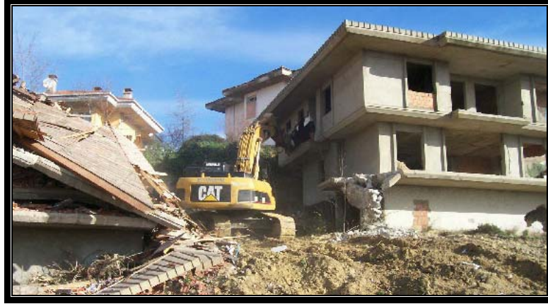
Şekil 3.6. Bölgede Yapılan Bir Yıkım Çalışması Örneği ( www.ibb.gov.tr )
