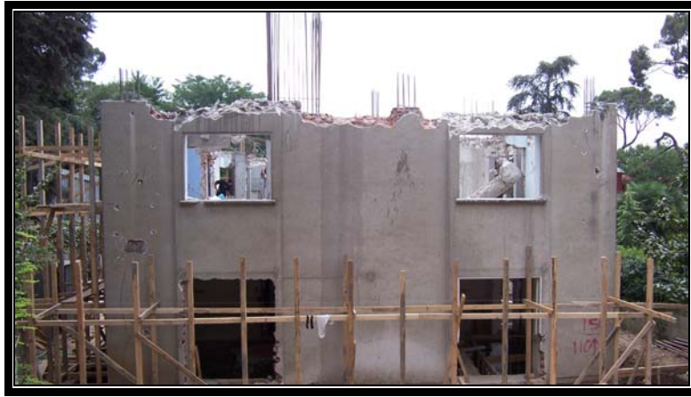
Şekil 3.13. Mevcut Taşıyıcı Sistemin Betonarme Olarak Değiştirilmesi Örneği
