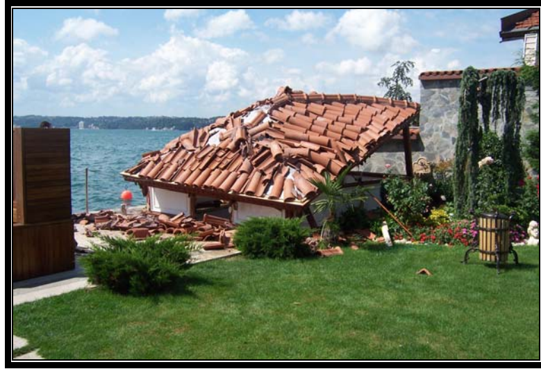
Şekil 4.15. Dolgu Alanında Kalan Bir Yapı Örneği
