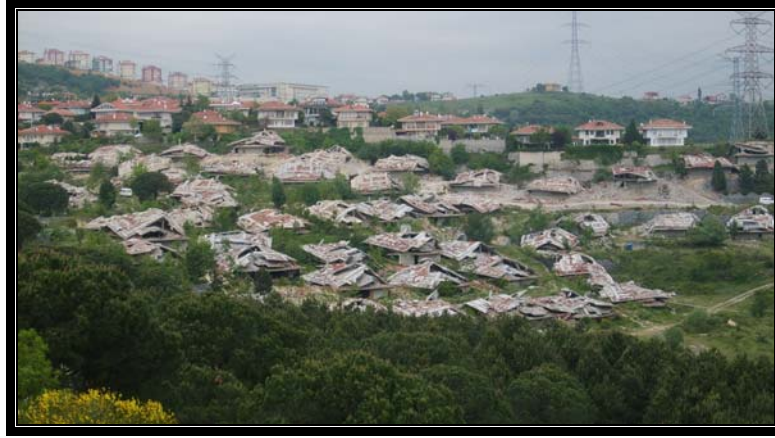
Şekil 4.12. Maden Mahallesi’ndeki Uyum Villalarının Yıkılmış Halinden Görünüm
