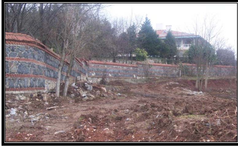
Şekil 3.4. Doğal Zeminin Tahrip Edilmesine Bir Örnek
