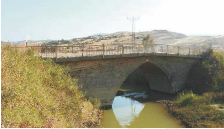
Şekil 5.40. Kumbağ Köprüsü (Orijinal 2018)
