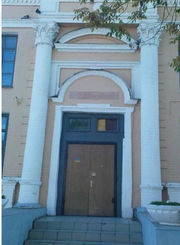
Resim 4.97: Kharkov Kenesası'nın giriş kapısı görünüşü. (Kaynak: https://commons.wikimedia.org/wiki/Category:Karaite_Kenesa_in_Kharkiv ).
