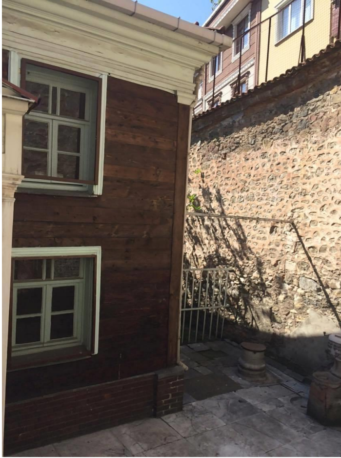
Resim 4.86: Hasköy Kenesası. Kuzey cephesinin köşe görünüşü (Ieva Vasiliauskaite)
