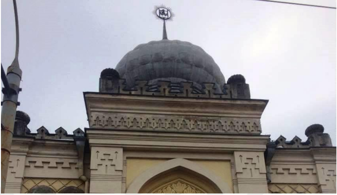
Resim 4.37: Vilnius Kenesas, çatı görünüşü (Ieva Vasiliauskaite)
