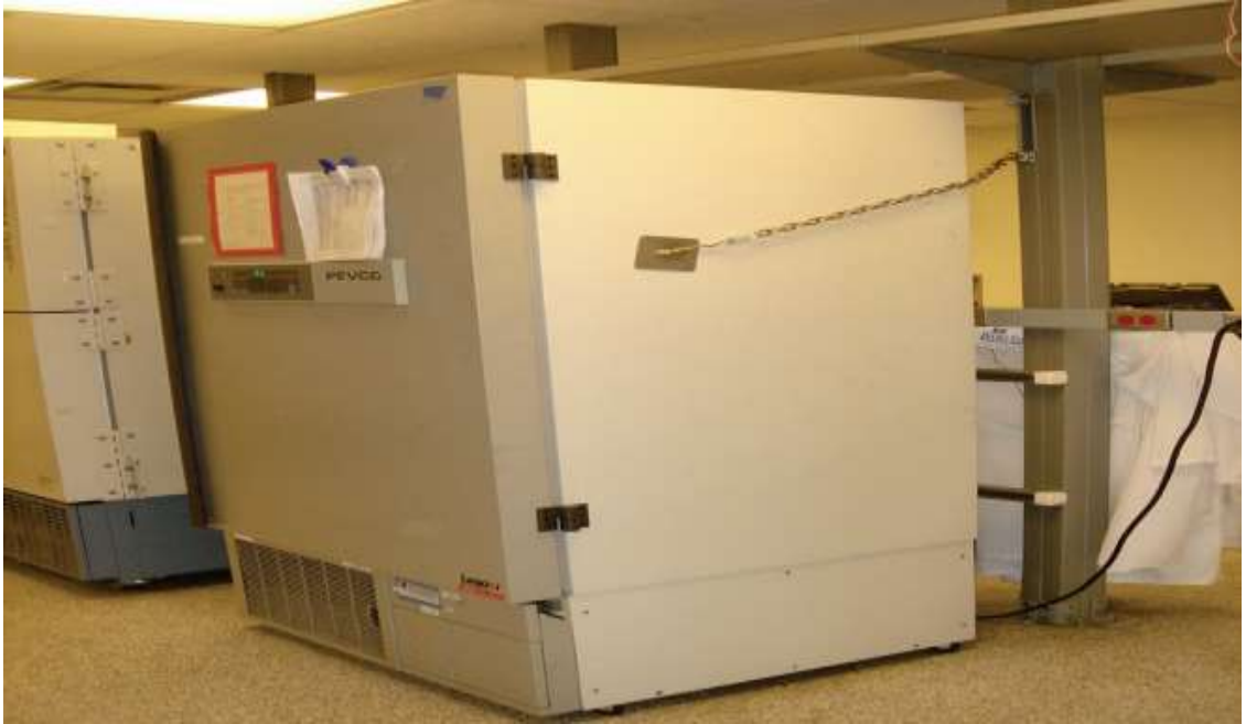
Şekil 10. Yapısal Olmayan Elemanların Sabitleme Örnekleri
