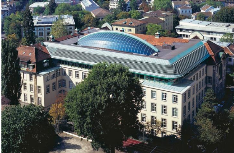
Şekil 3.56: Zürih Üniversitesi ek kütüphane binası dış görünüş (Url-8).
