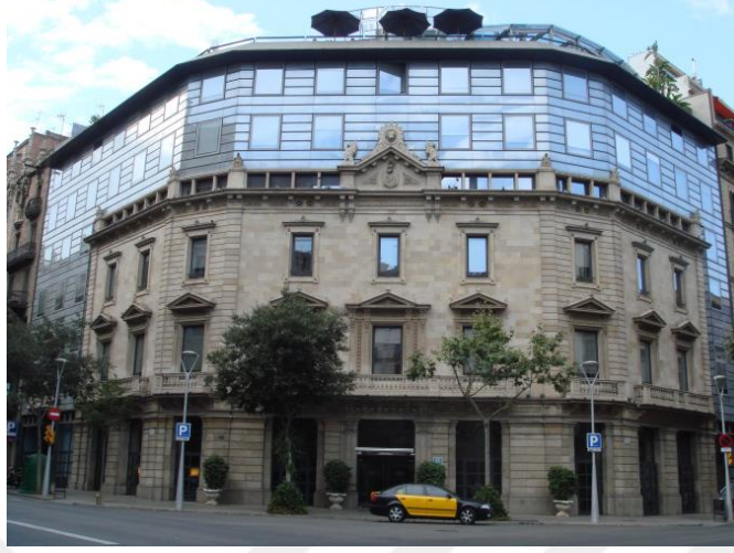
Şekil 1.2: Fasadizm yaklaşımına örnek, Barselona’da Carrer Pau Claris binası (Url-22).
