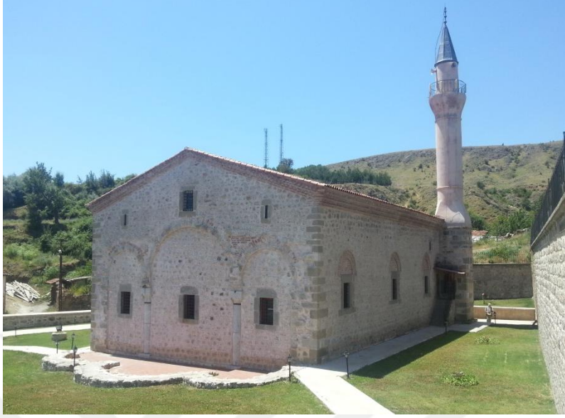
Şekil 2.3: Olumlu bir uyarlanabilir yeniden kullanım örneği olarak, Merzifon, Gümüşhacıköy’de Cami işleviyle yeniden kullanılan bir Rum Kilisesi binasına ait dış görünüm (2013).
