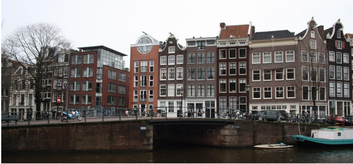
Şekil 1.1: Amsterdam şehrinden tarihi dokuda “dolgu” (infill) yeni yapı uygulaması içeren bir sokak silüeti.
