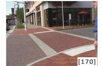
[170] Girişi simgelemek ve hız sınırlandırılması için rampa
