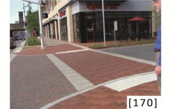
[170] Girişi simgelemek ve hız sınırlandırılması için rampa
