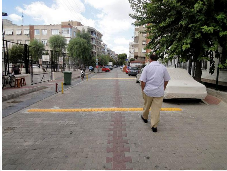
Şekil 4.5 Özellikle okul önlerine uygulanan kasis örneği [126].
